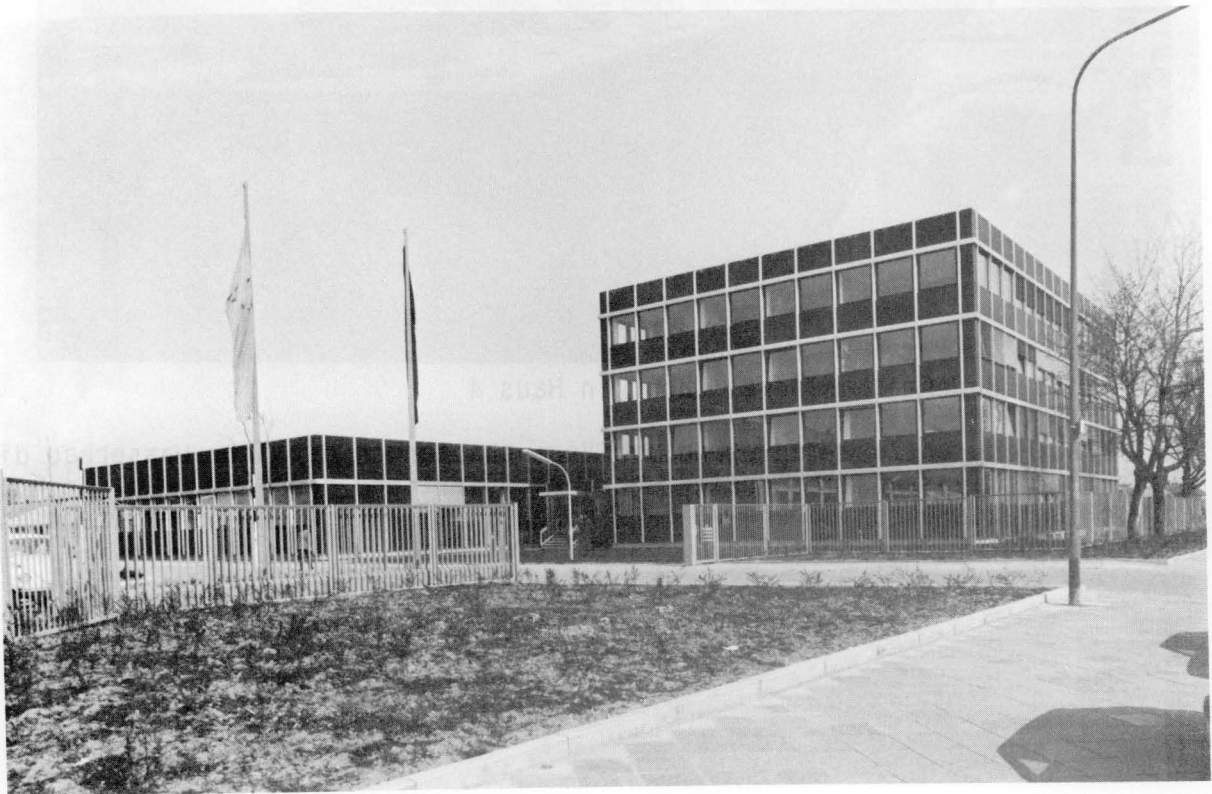
Bild 1/12: Hauptgebäude (Haus 1) mit Rechenzentrum (Haus 2)
