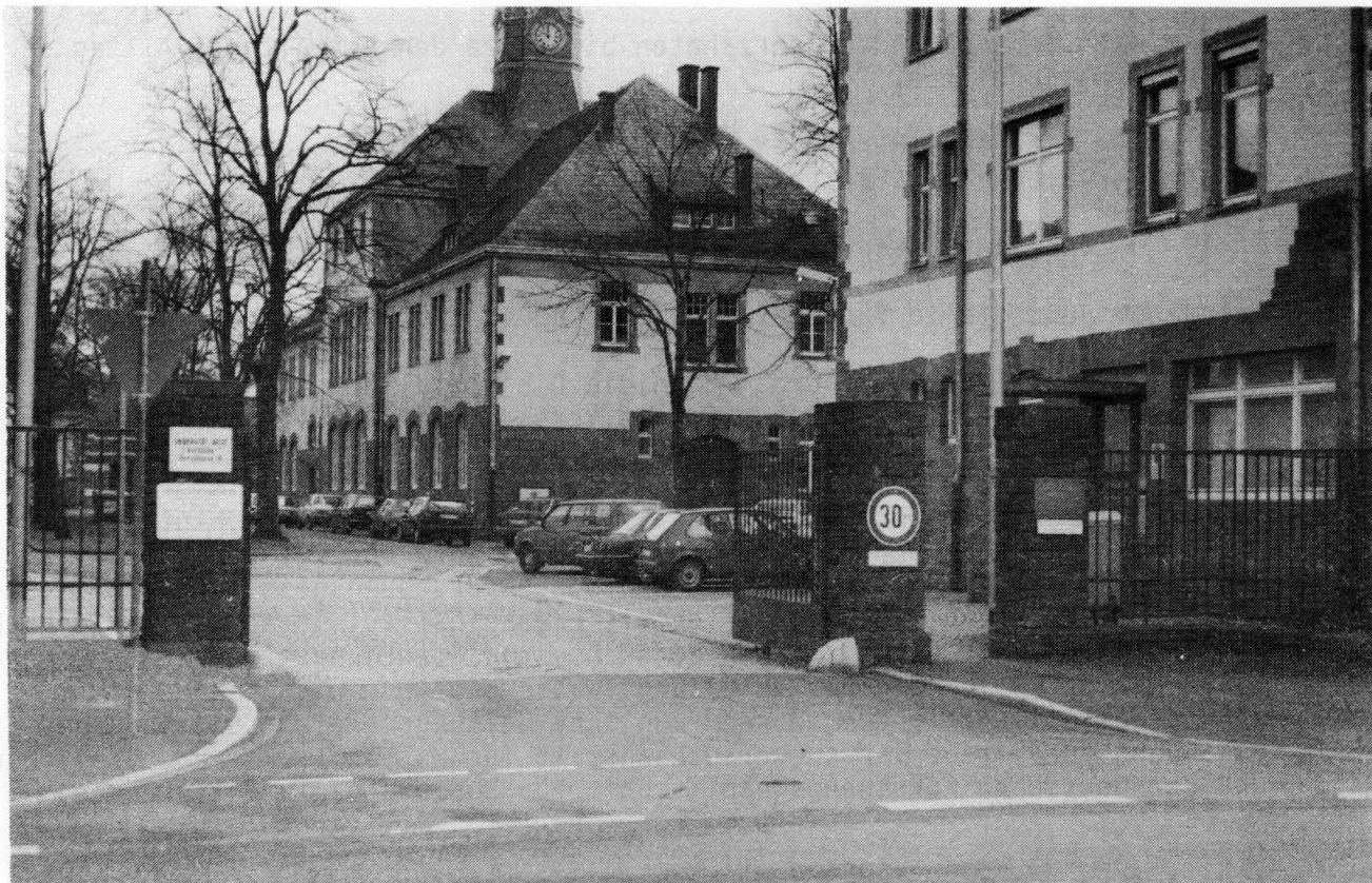
Bild 1/1: Einfahrt in die ehemalige "Telegraphenkaserne"
