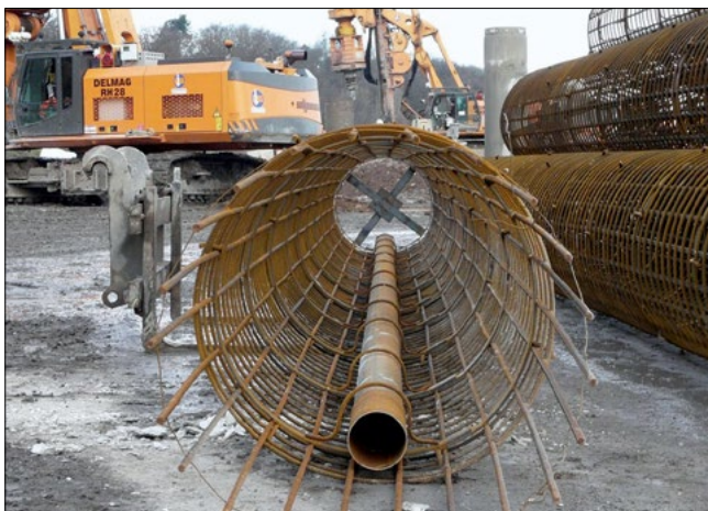
Bild 13: Inklinometerschutzrohr im Bewehrungskorb (Quelle: NBA Hannover)
