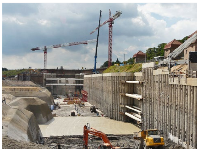
Bild 3: Blick nach Süden in die Baugrube im Endaushub (Quelle: NBA Hannover)
