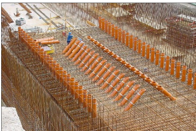
Bild 2: Herstellen der Druckkammerdecke/Schleusenkamersohle der Schleuse Süfeld mit der verlorenen Schalung für die Fülldüsen (Quelle: NBA Hannover)
