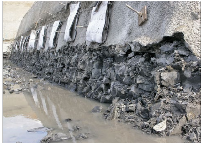
Bild 14: Konstruktive Sicherung der Felsböschungen mit Spritzbeton, Felsnägeln und Drainagevliesen
