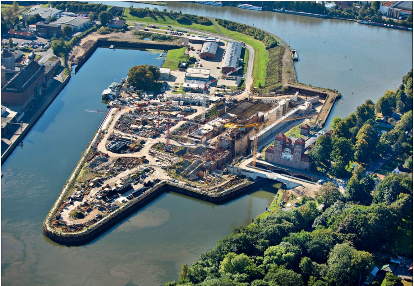
Bild 1: Luftbild mit der bestehenden Schachtschleuse in Minden und der im Bau befindlichen Weserschleuse (Quelle: BAW)
