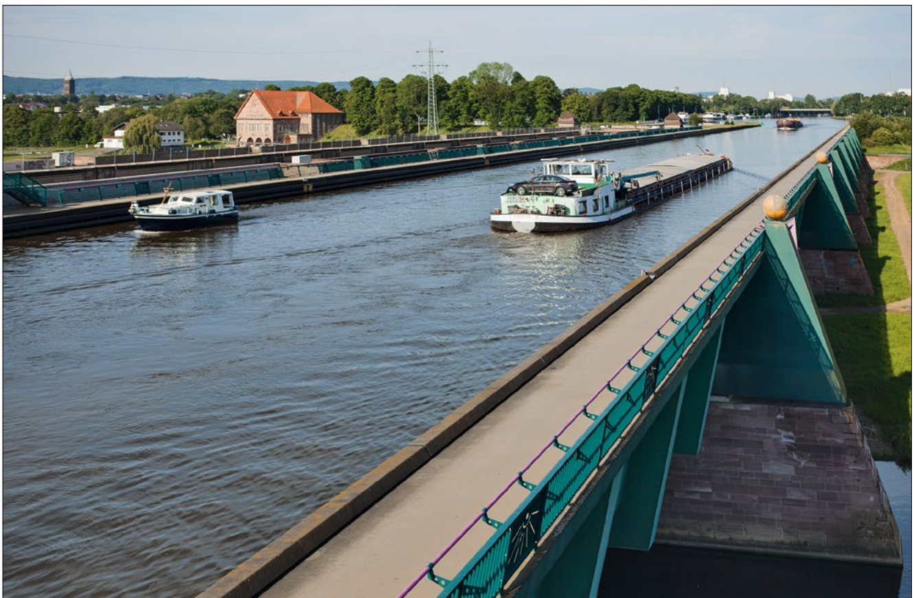
Bild 7: Ansicht von Nord-Ost, im Hintergrund das Hauptpumpwerk (2014)
