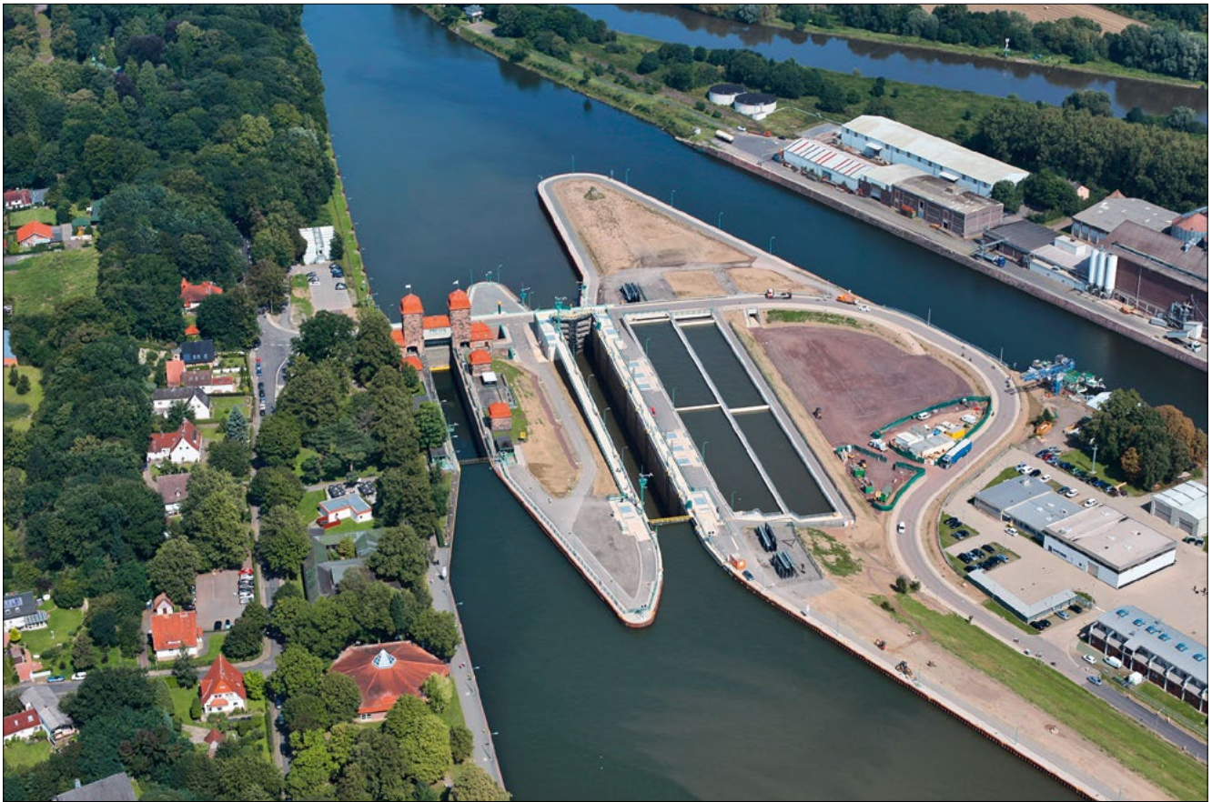
Bild 16: Luftbild der neuen Weserschleuse Minden
