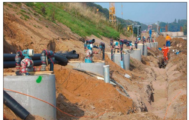
Bild 9: Herstellung der Absenkbrunnen
