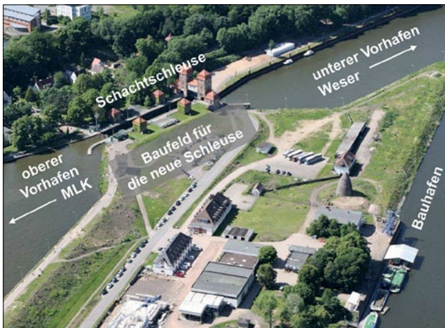
Bild 1: Luftbild mit der bestehenden Schachtschleuse in Minden vor Beginn der Baumaßnahmen für die neue Weserschleuse (Quelle: WSV)
