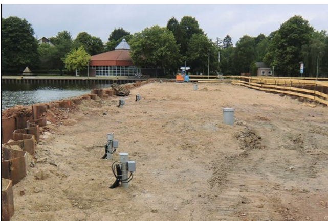
Bild 15: Grundwassermessstellen (links) und Entnahmebrunnen (rechts) im Fangedamm (Quelle: NBA Hannover)
