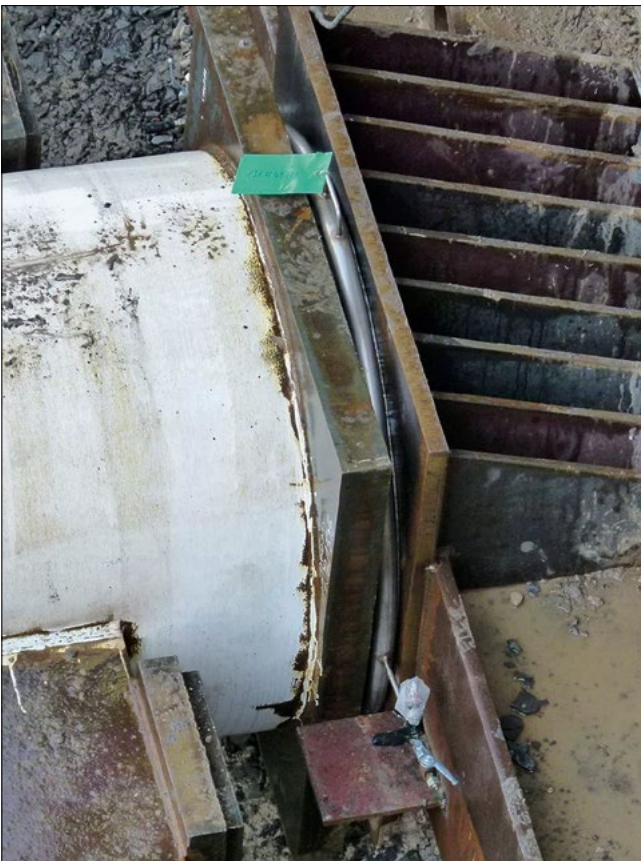
Bild 5: Einsatz der Kapselpresse zur Steifenkraftmessung im Messquerschnitt 1–1 (Quelle: NBA Hannover)
