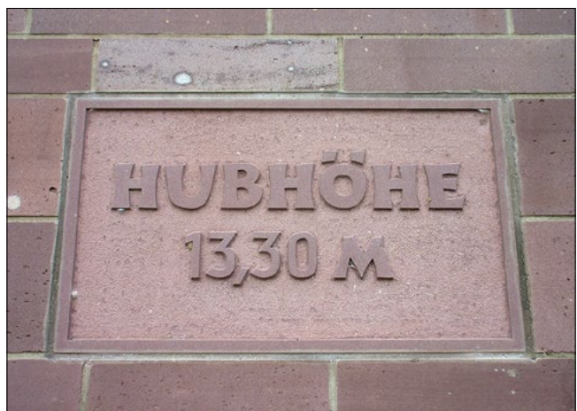
Bild 9: Hubhöhenangabe an der Unterhauptfassade
