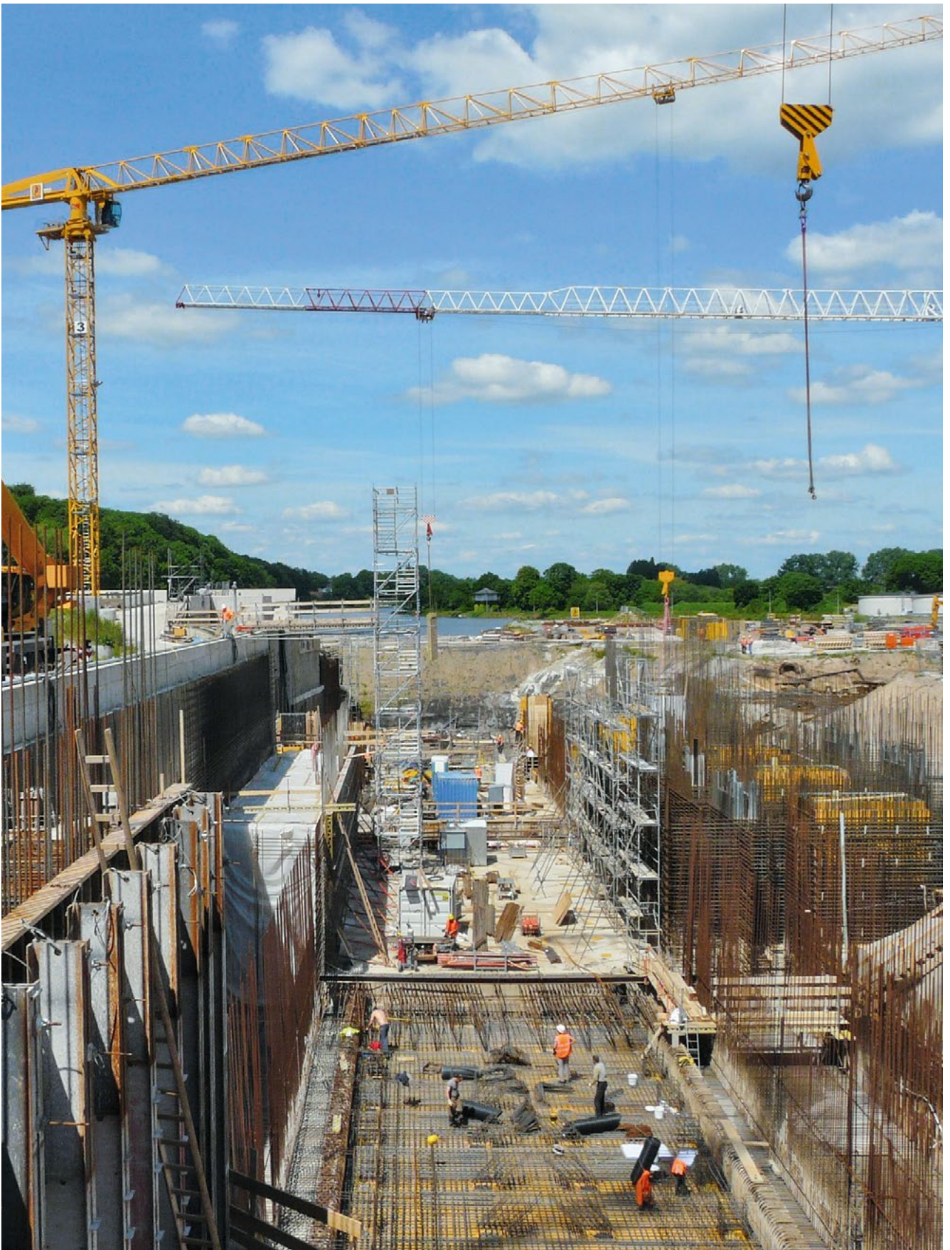
Bild 3: Schleusenkammer im Rohbau, Blick Richtung Unterwasser (Weser), Juni 2013 (Quelle: NBA Hannover)
