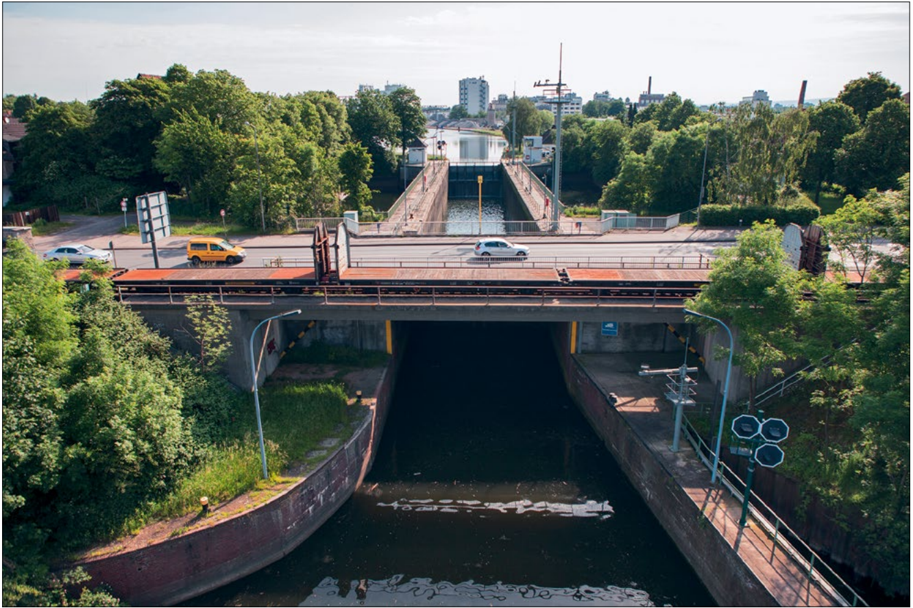
Bild 17: Untere Schleuse Minden, Ansicht vom Unterwasser (2005)
