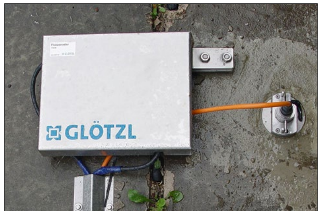
Bild 17: Installation von Neigungssensoren (rechts im Bild) in der Kammerwand der Schachtschleuse (Quelle: NBA Hannover)
