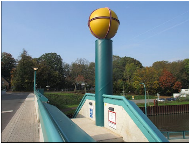
Bild 11: Robuste Brüstungsabdeckungen am gesamten Bauwerk
