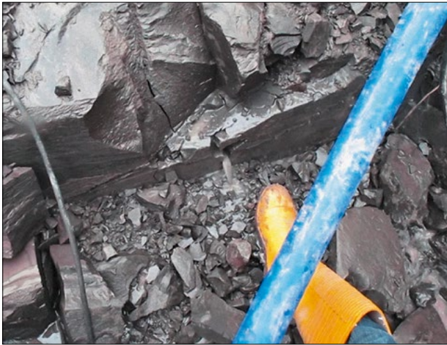
Bild 18: Wasseraustritte im Tonstein beim Aushub der Baugrube
