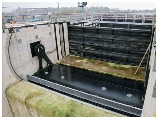
Bild 6: Dammbalkenverschluss vor dem Obertor
