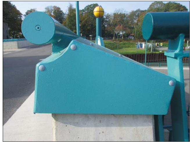
Bild 12: Konkave Form der Abdeckung und der Handlauf bilden konzentrische Kreise
