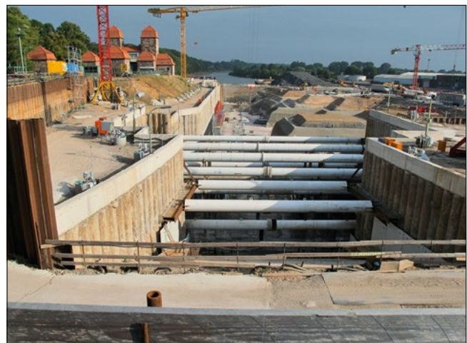
Bild 6: Blick in die Baugrube im Zustand des Endaushubs
