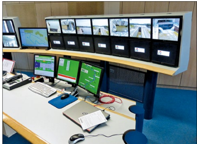
Bild 7: Bedienplatz in der Leitzentrale
