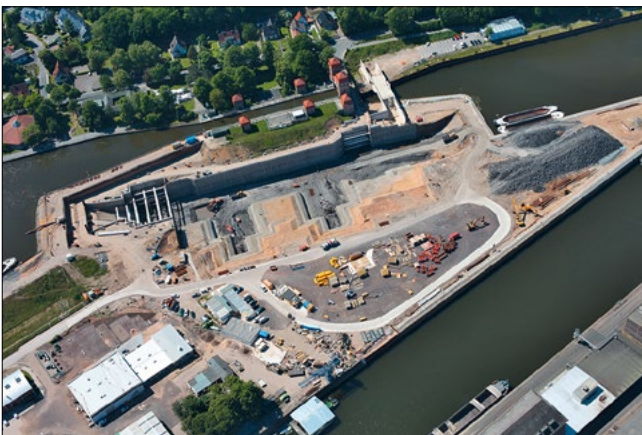
Bild 11: Luftbild der Baugrube
