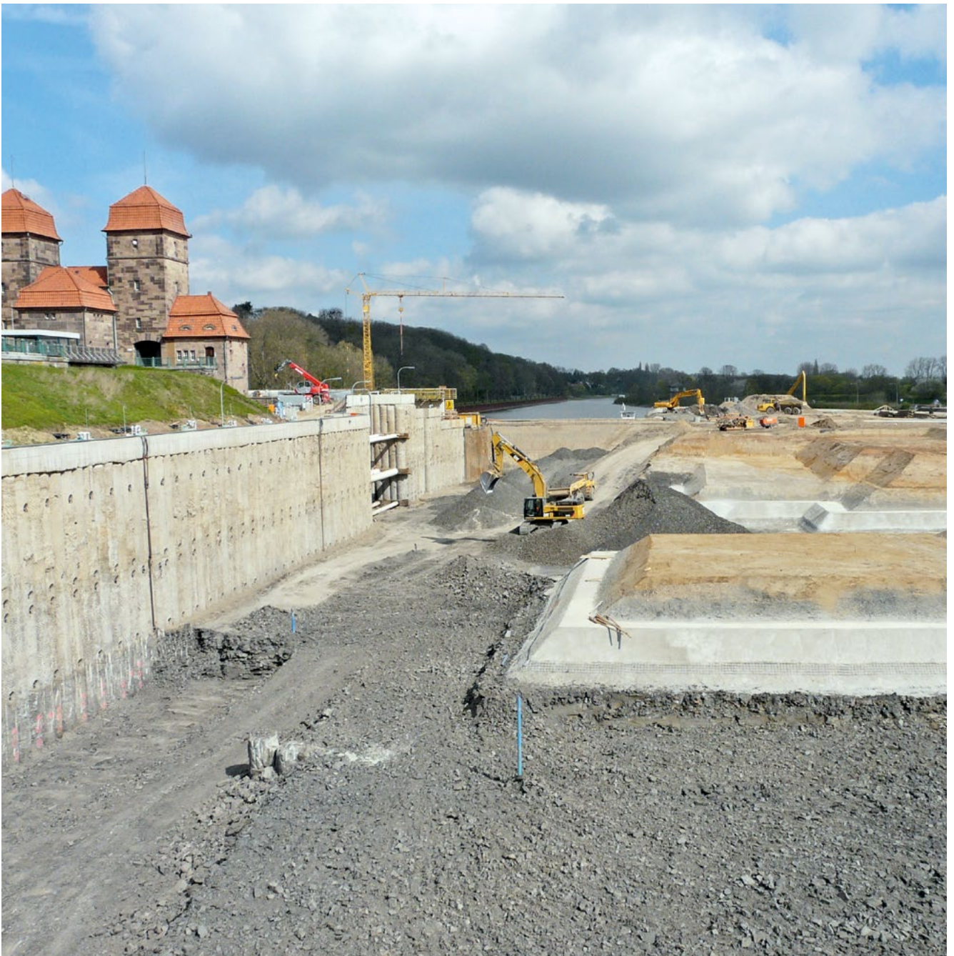
Bild 1: Baugrube für die Schleusenkammer kurz vor dem Endaushub, Bohrpfehlwand (links) und geböschte Baugrube für die Anschlüsse der Sparbecken (rechts), April 2013 (Quelle: NBA Hannover)
