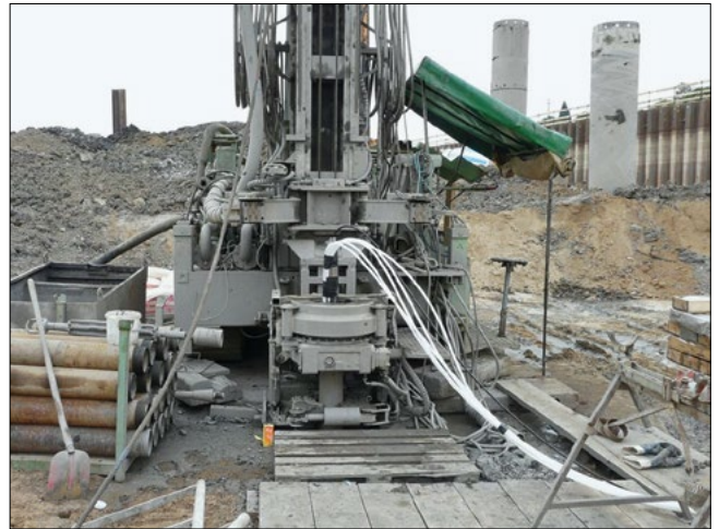
Bild 11: Einbau eines Sohlextensometers (Quelle: NBA Hannover)
