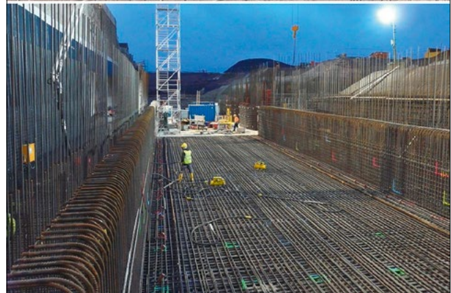
Bild 3: Bewehrung im Sohlenbereich der alten Schachtschleuse (oben) und der neuen Weserschleuse (Quelle: oben BAW, unten NBA Hannover)
