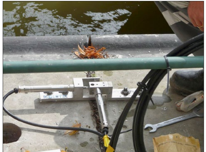
Bild 16: 2D-Fissurometer auf der Planie der Schachtschleuse (Quelle: NBA Hannover)
