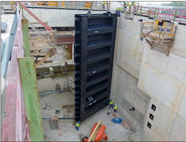
Bild 15: Einbau des Untertores
