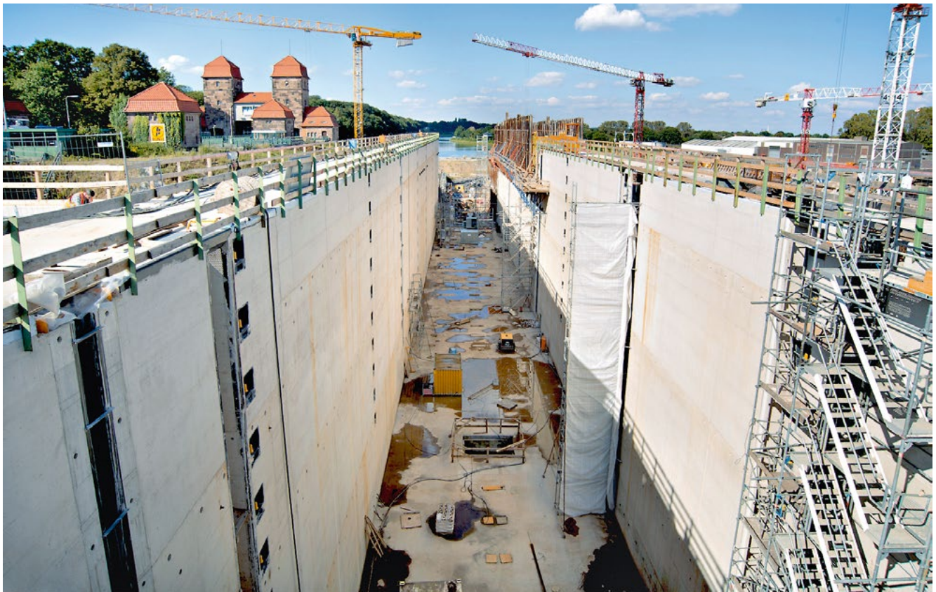
Bild 5: Kammer der neuen Weserschleuse kurz vor Fertigstellung des Rohbaus, Blick nach Unterwasser in Richtung Weser, links ist das Unterhaupt der alten Schachtschleuse erkennbar, August 2017
