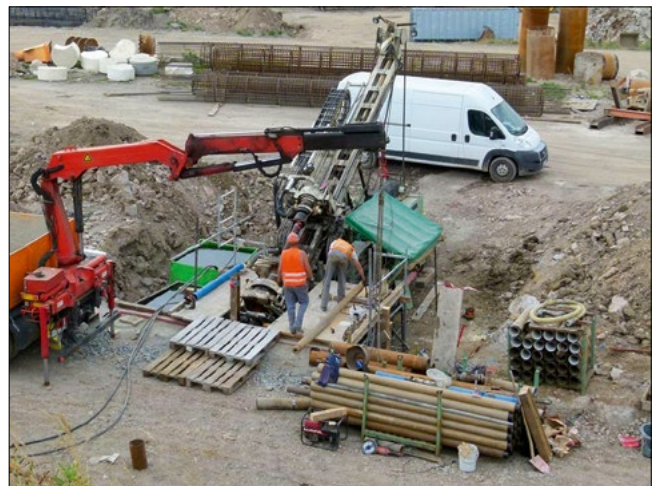
Bild 12: Bohrung für ein 65-Meter-Schrägextensometer (Quelle: NBA Hannover)
