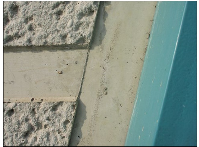
Bild 6: Guter Sichtbeton mit Matrizenstruktur und Spiegel
