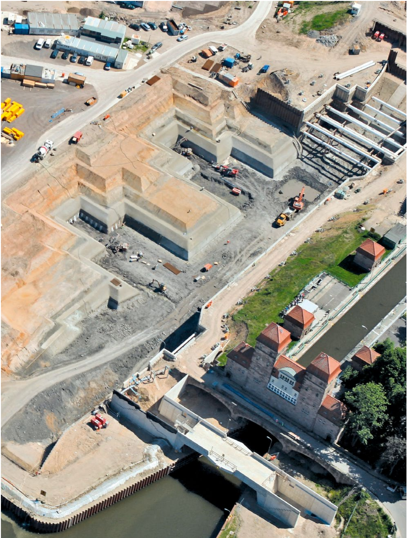
Bild 2: Blick in die Baugrube mit Aussteifung am Oberhaupt, Böschung zur Weserseite und im Bereich der Sparbeckenzuläufe, Bohrfahlwand zur alten Schachtschleuse, Juni 2012 (Quelle: NBA Hannover)
