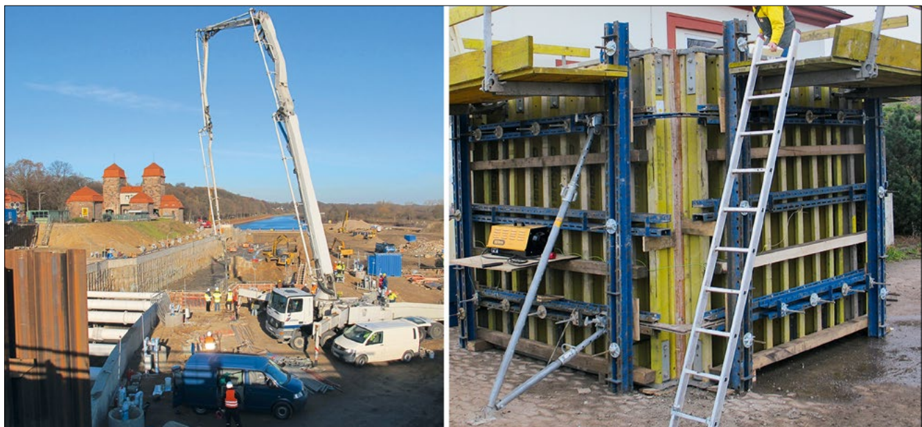
Bild 1: Pumpversuche und Herstellung eines 8 m 3 -Blocks im Rahmen der Eignungsprüfungen
