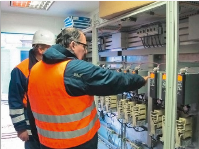
Bild 11: Steuerungsanlage für den Betrieb der Wasserhaltung
