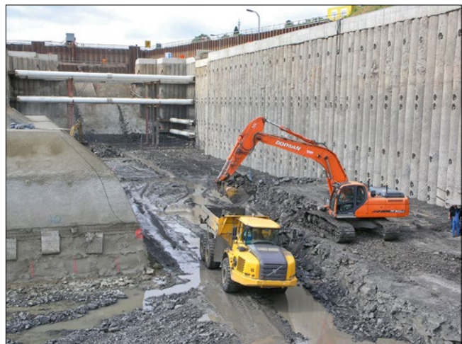
Bild 17: Entfestigter und teilweise plastifizierter Tonstein auf der Aushubebene
