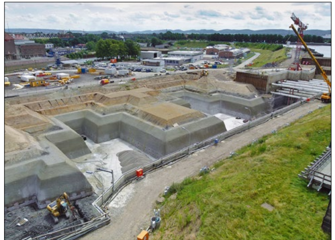
Bild 12: Blick auf die östliche Baugrubenböschung
