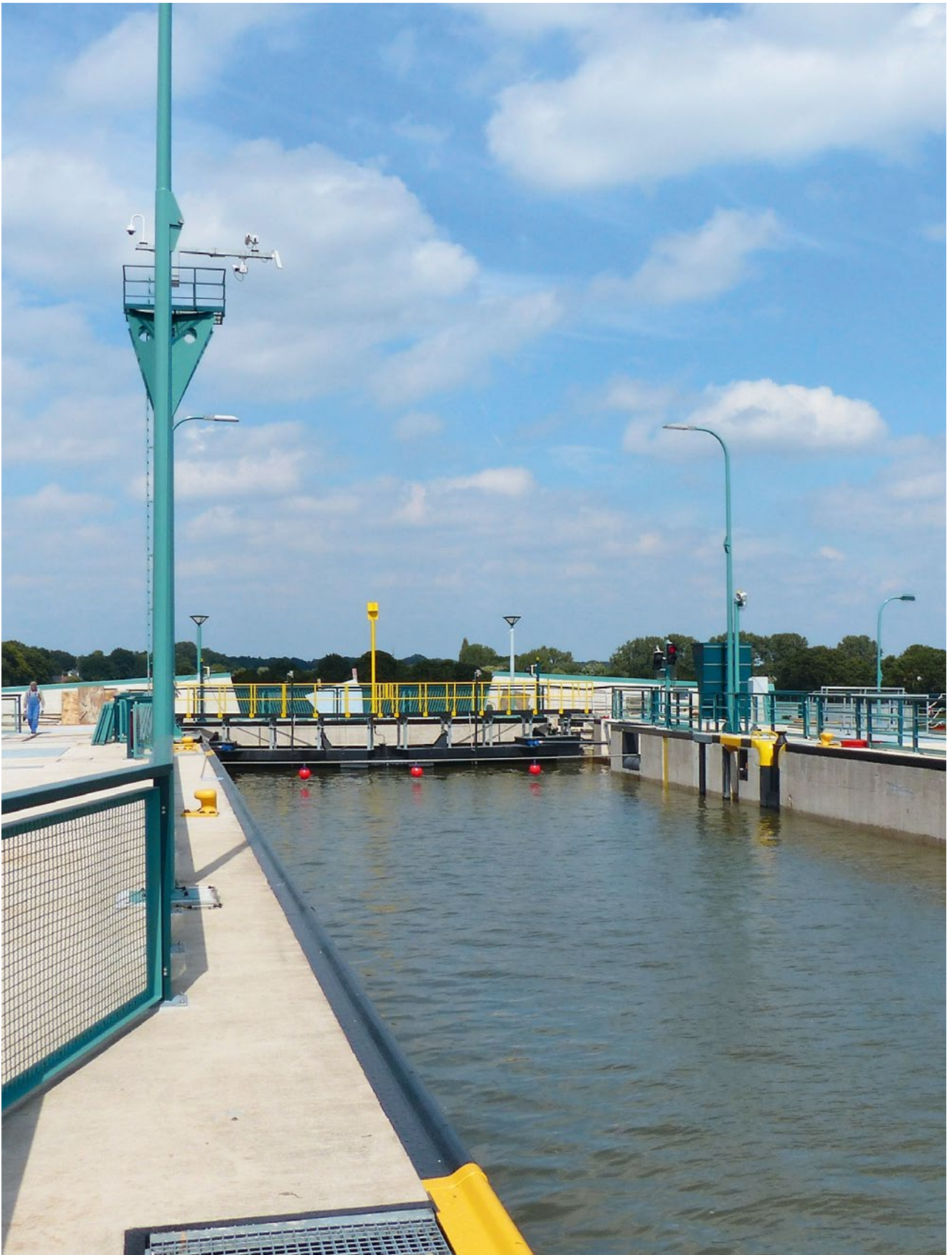
Bild 7: Gefüllte Kammer der neuen Weserschleuse mit Blick über das Unterhaupt in Richtung Unterwasser (Weser), August 2017 (Quelle: NBA Hannover)
