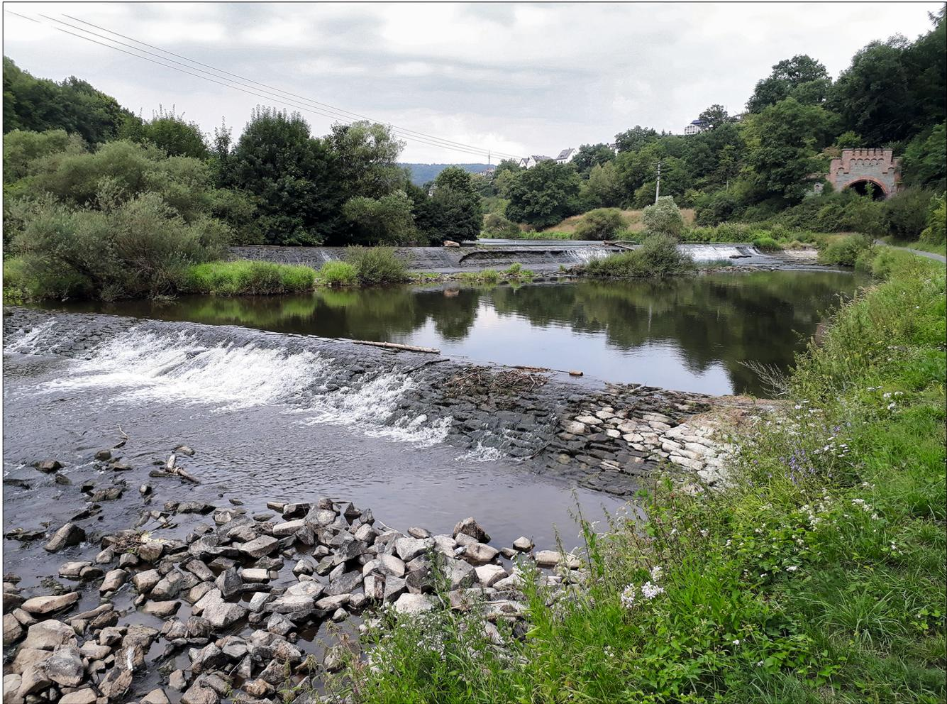
Bild 1: Wehre bei Kirschhofen an der Lahn (Bj. 1859): Oberes Wehr, Länge 110 m, gepflasterter Wehrkörper, und unteres Wehr, Länge 60 m (Grunddaten des WSA Koblenz)
