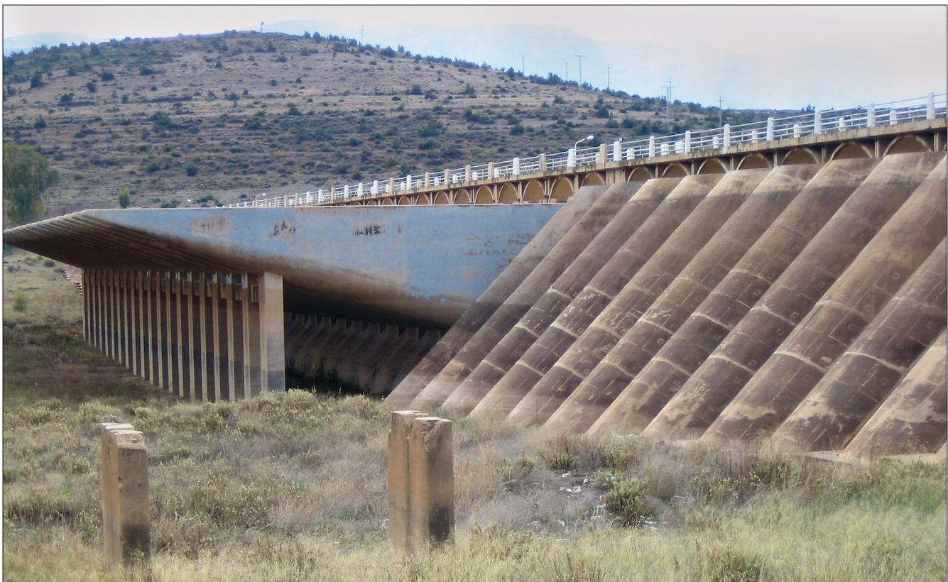
Bild 3: Piano-Key-Wehr an der Staustufe Beni Bahdel in Algerien (Quelle: Volker Bettzieche, Ruhrverband, 2004/2005)
