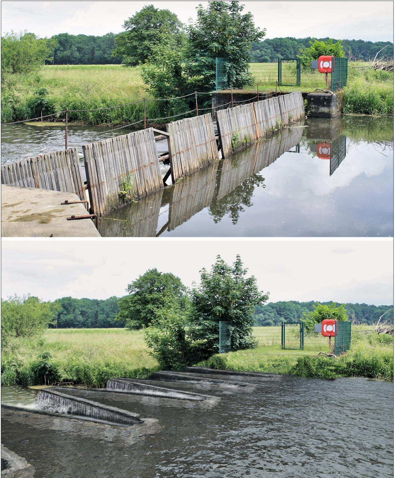
Bild 12: Visualisierung des Labyrinth-Wehres am Standort Bardowick: Ist-Zustand (oben), Planungszustand (unten)
