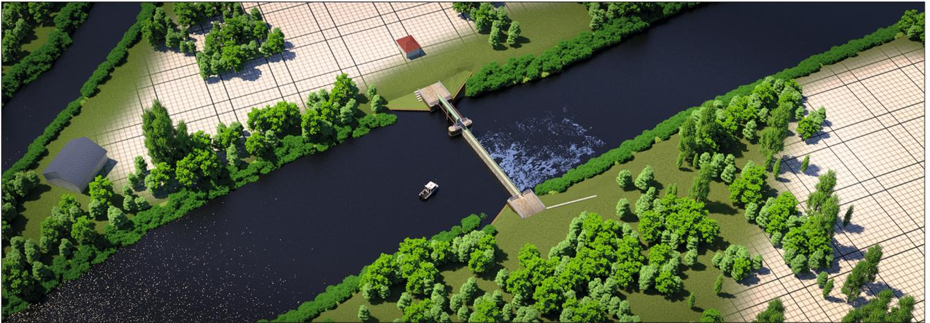
Bild 14: Kombiniertes Nadel- und Schützenwehr an einer mehrachsigen Staustufe an einer Wasserstraße der Wasserstraßenklasse II
