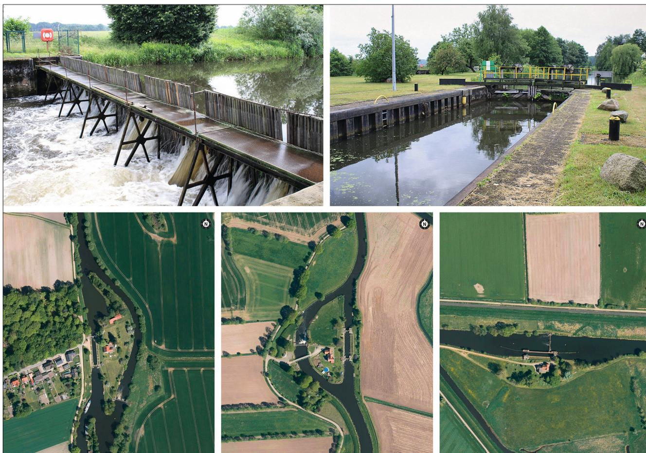
Bild 3: Oben links: Nadelwehr an der Staustufe Bardowick; oben rechts: Schleuse an der Staustufe Bardowick; unten: Draufsicht auf die Staustufen Bardowick, Wittorf und Fahrenholz (Ilmenau) (Quelle der unteren Bilder: GeoViewer)
