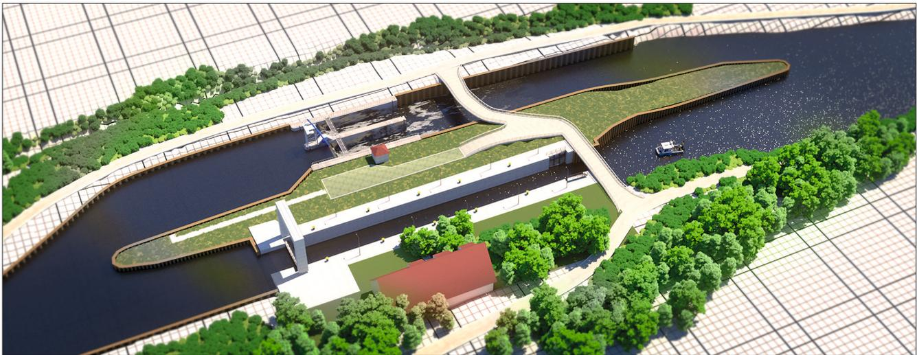
Bild 8: Zweifeldriges Klappenwehr an einer einachsigen Staustufe der Wasserstraßenklasse I
