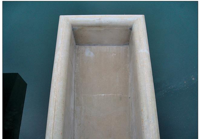
Bild 24: Blick von oben auf einen Outlet-Key mit vertikalen Brüstungswänden (Parapet Walls)
