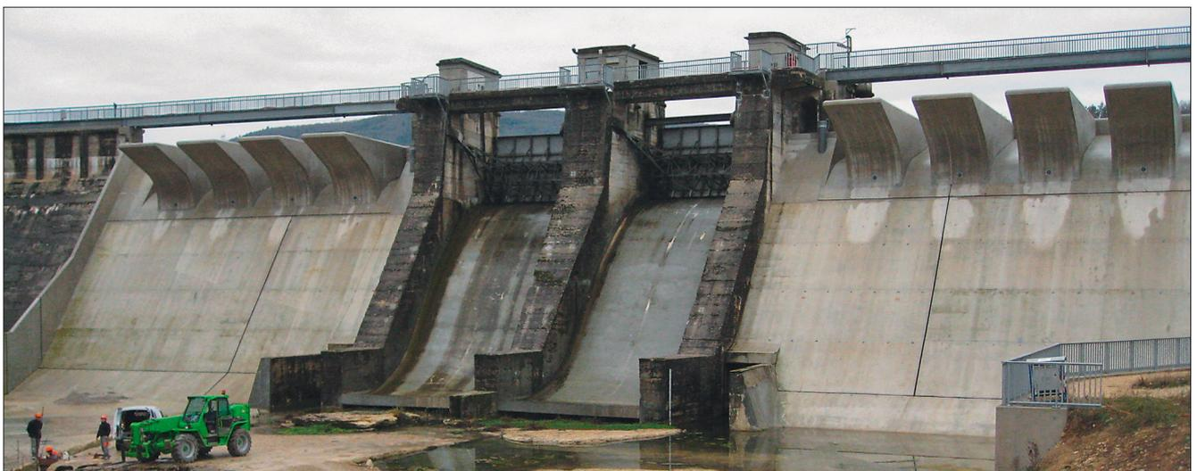
Bild 25: Piano-Key-Wehr auf der Staumauer der Barrage de Charmines (Frankreich)
