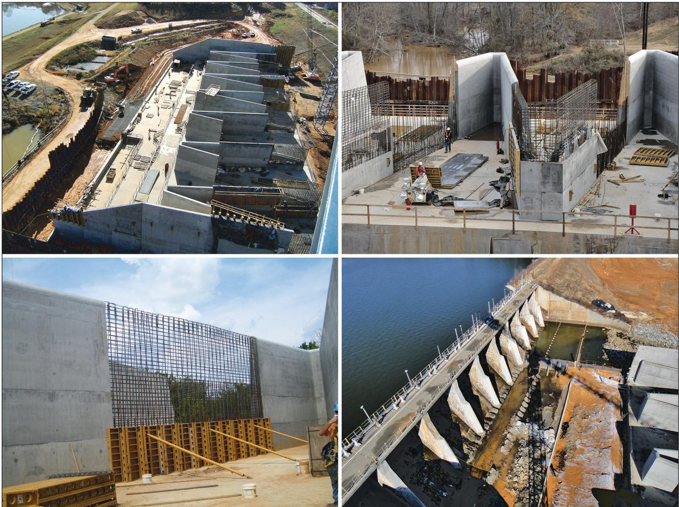
Bild 22: Aufnahmen aus der Bauzeit des Labyrinth-Wehrs am Lake Townsend (Quelle: Brian Crookston, Utah State University)
