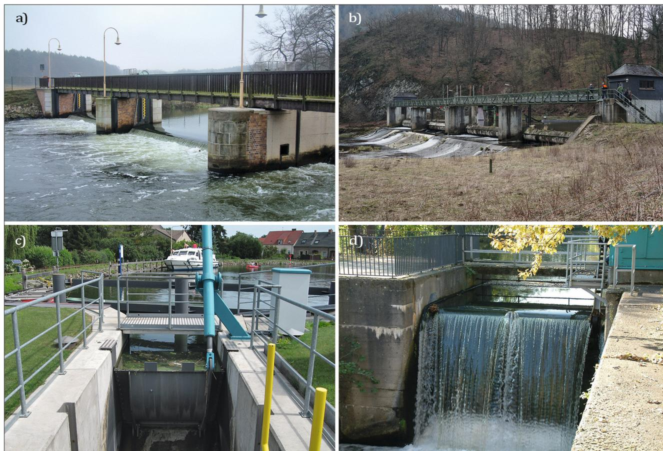
Bild 4: Beispiele von beweglichen Wehren an Wasserstraßen außerhalb des Kernnetzes: a) Spree-Oder-Wasserstraße; b) Lahn; c) Storkower Gewässer und d) Finowkanal
