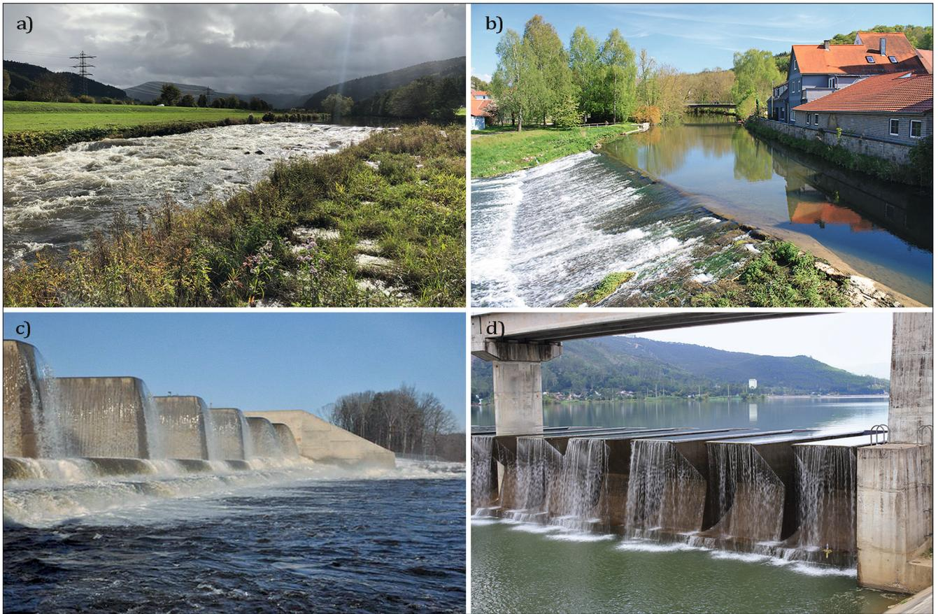
Bild 3: Geeignete feste Wehrtypen bzw. Sohlenbauwerke: a) Sohlgleite; b) Streichwehr; c) Labyrinth-Wehr (Quelle: Brian Crookston, Utah State University) und d) Piano-Key-Wehr
