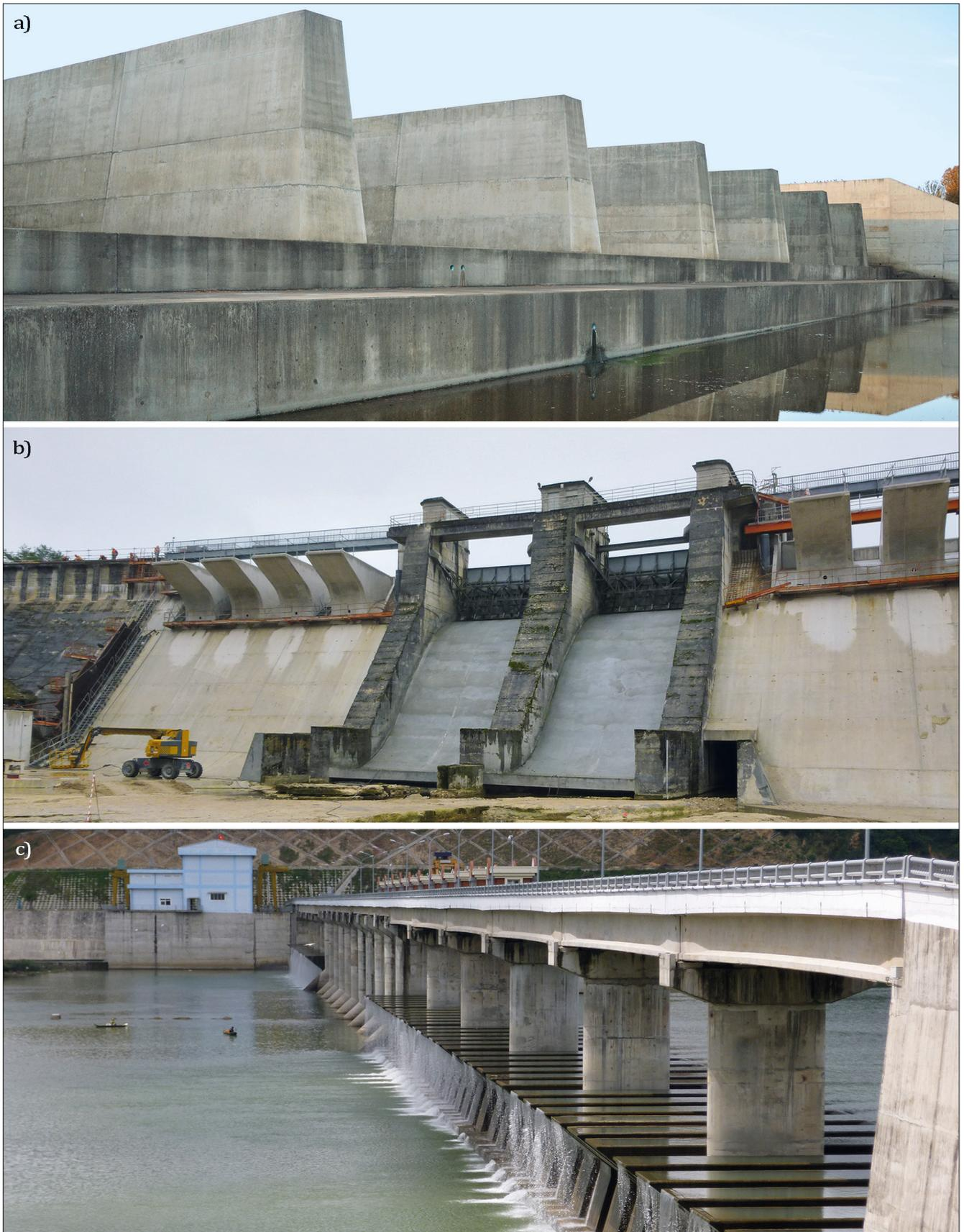
Bild 2: Foto (a) eines Labyrinth-Wehrs als Hochwasserentlastungsanlage am Lake Townsend (Quelle: Brian Crookston, Utah State University), (b) des PKW als Hilfs-Hochwasserentlastungsanlage auf der Staumauer in Charmines, Frankreich, und (c) des Van Phong PKW als Flusswehr, Vietnam
