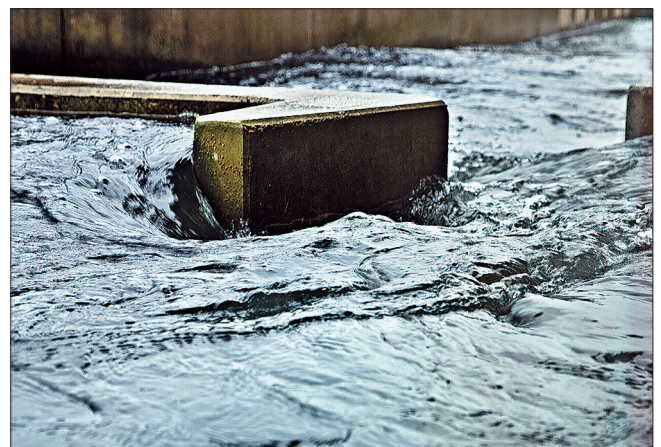
Bild 1: Strömungsablösungen an den Einbauten im Bereich der Trennwand eines Schlitzpasses
