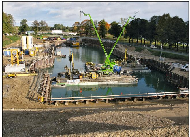
Bild 7: Einbau der Auftriebspfähle
