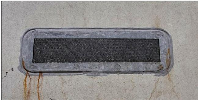
Bild 5: Undichte Fuge: Wassereintritt am Anodenkörper
