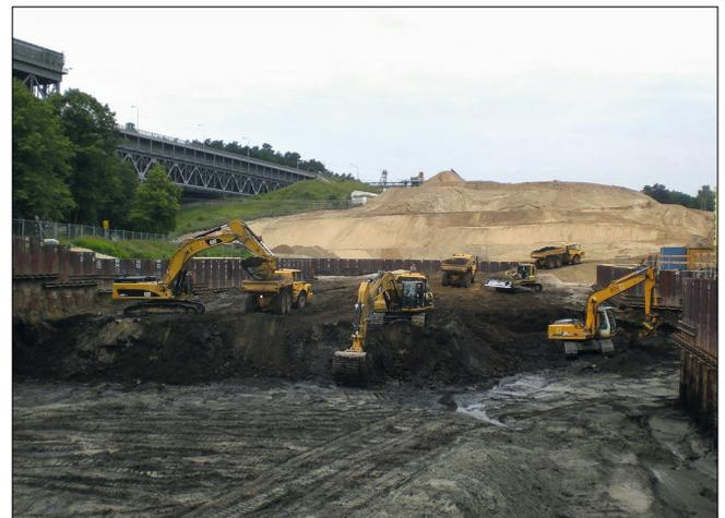
Bild 11: Aushub Torfschicht (Quelle: JOHANN BUNTE Bauunternehmung GmbH & Co. KG)
