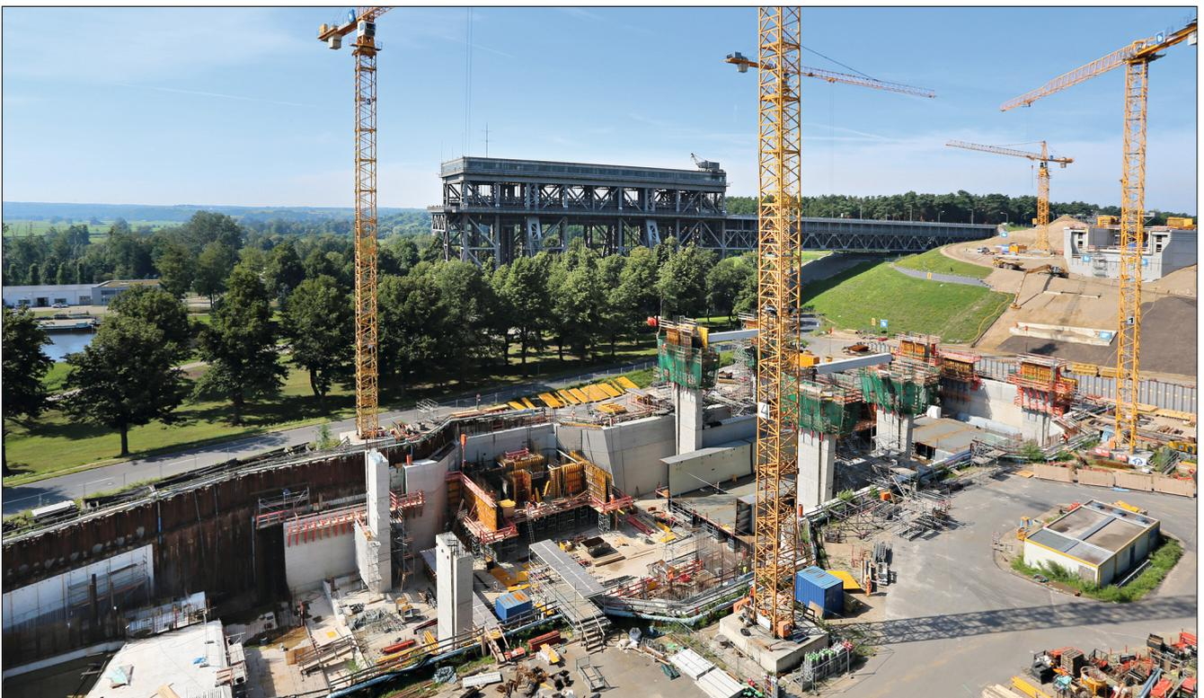
Bild 1: Bauzustand Trog, aufgehende Bauteile und oberes Widerlager (Januar 2012)
