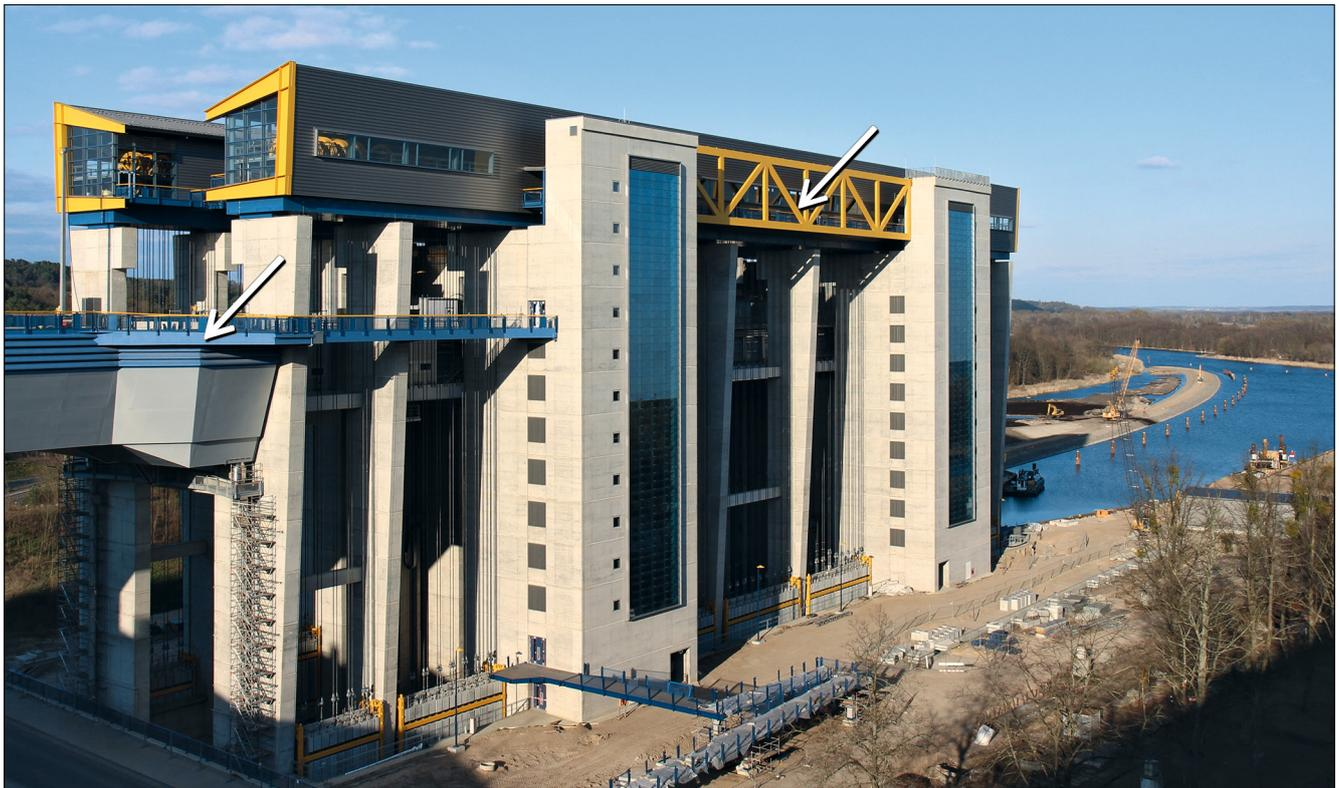
Bild 5: Lage der Messstellen an der Kanalbrücke und dem Zitatträger mit Pfeil gekennzeichnet
