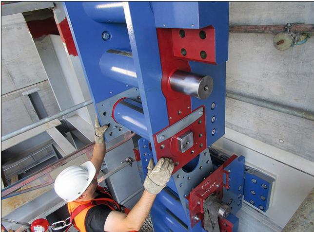
Bild 23: Montage Triebstockleiter
