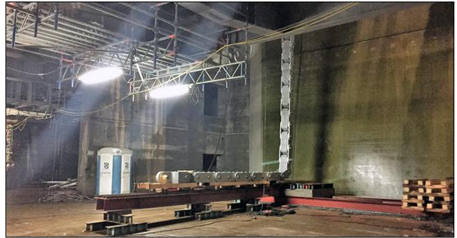
Bild 16: Montage der Seilgewichtausgleichskette (Quelle: SIEMAG TECBERG GmbH)
