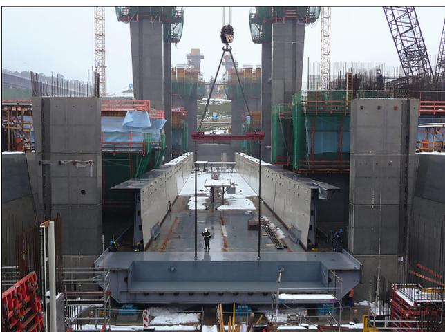
Bild 12: Montage Bodenteil Trogtormulde
