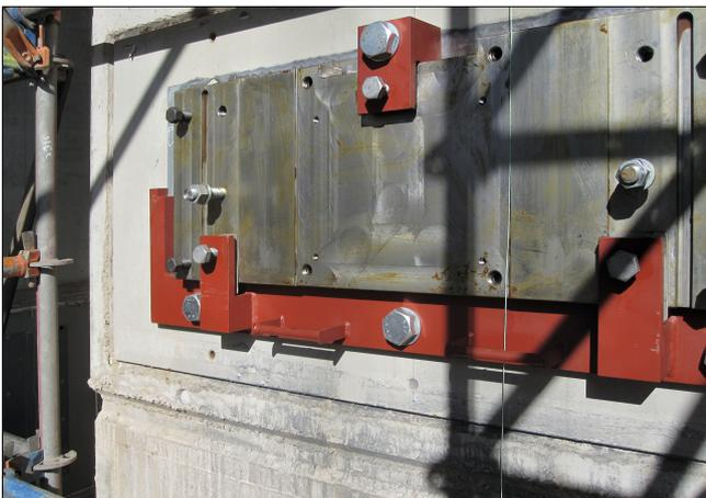
Bild 24: Hilfskonstruktion Gleitplatte
