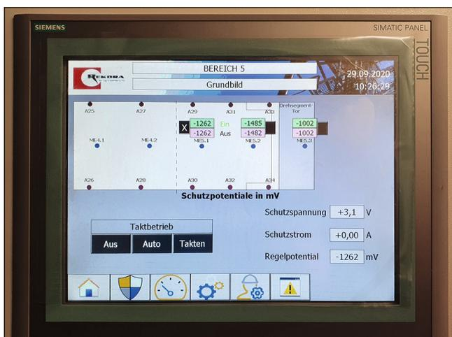
Bild 3: Sensorbildschirm vom Schaltschrank der Kanalbrücke mit den zwei Regelkreisen 4 und 5
