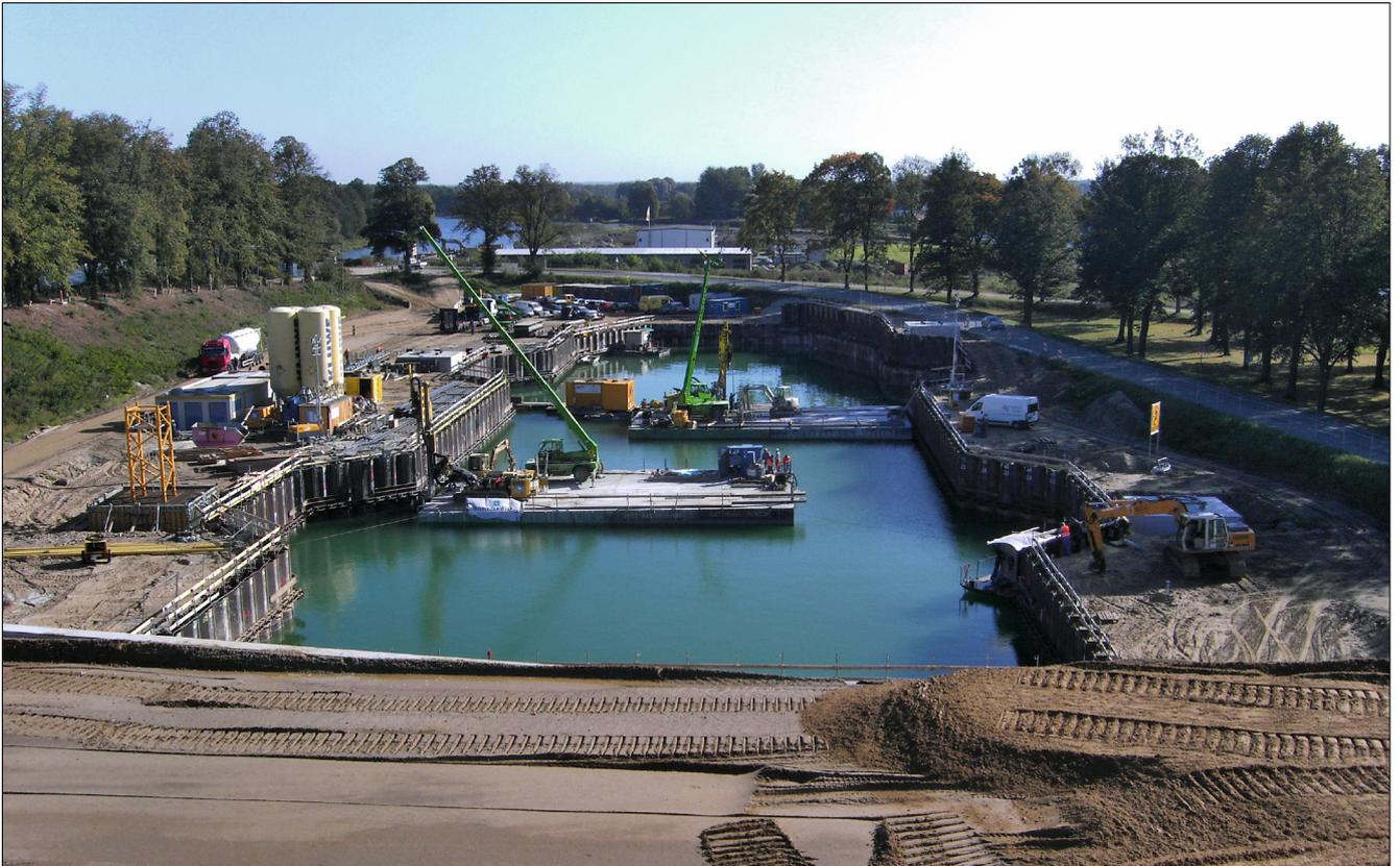
Bild 14: Sohlverankerungsarbeiten Oktober 2009
