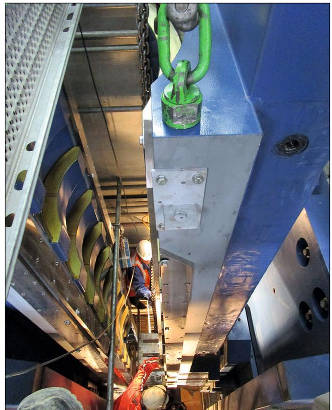
Bild 27: Einbau Mutterbackensäule
