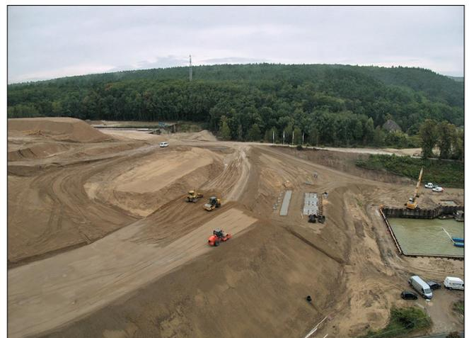
Bild 19: Zusätzliche Überprüfung der erreichten Verdichtung mit FDVK während der Erdarbeiten am Ende des oberen Vorhafens im Hebewerksbereich (Quelle: JOHANN BUNTE Bauunternehmung GmbH & Co. KG)
