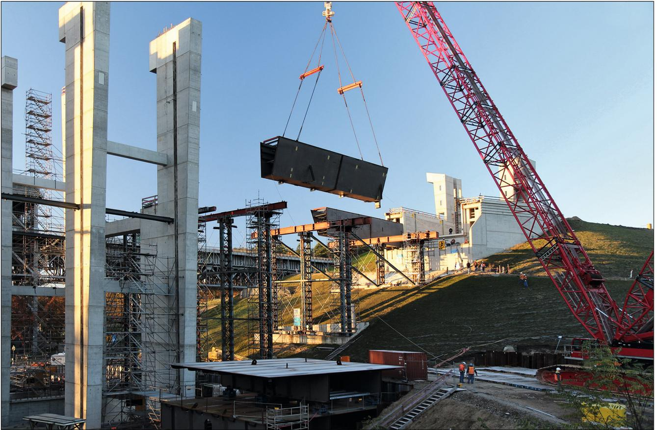
Bild 16: Einhub Kanalbrücke
