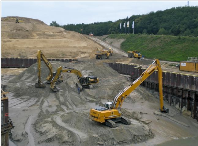
Bild 12: Aushub Sandmaterial (Quelle: JOHANN BUNTE Bauunternehmung GmbH & Co. KG)
