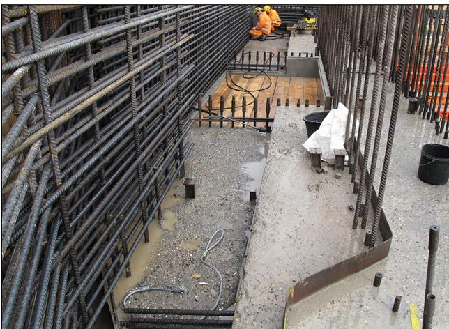
Bild 5: Ordnungsgemäß vorbehandelte Arbeitsfugen der Trogaußenwand
