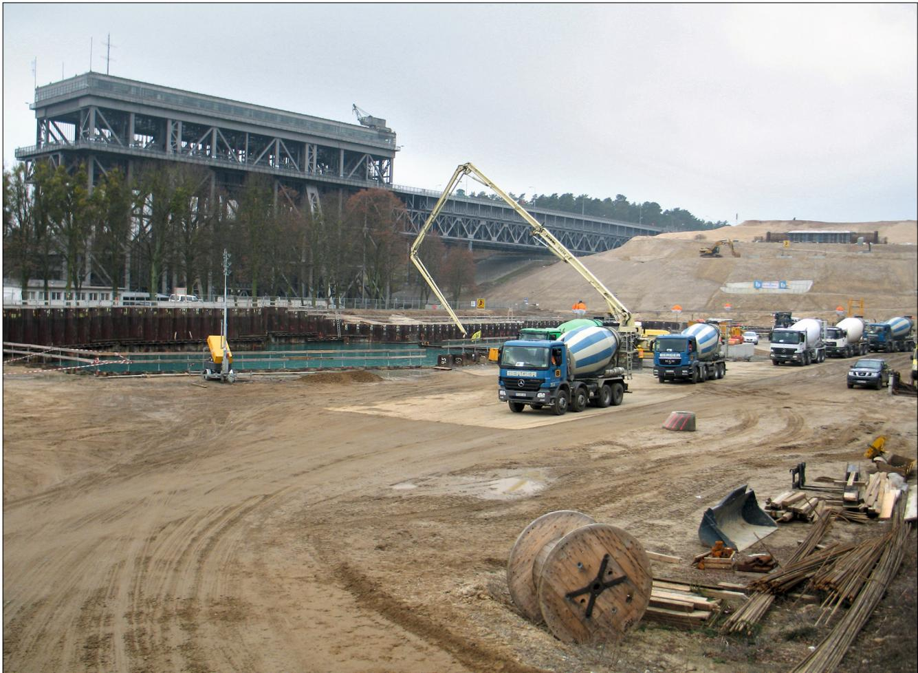
Bild 3: Betonage Unterwasserbetonsohle (März 2010)
