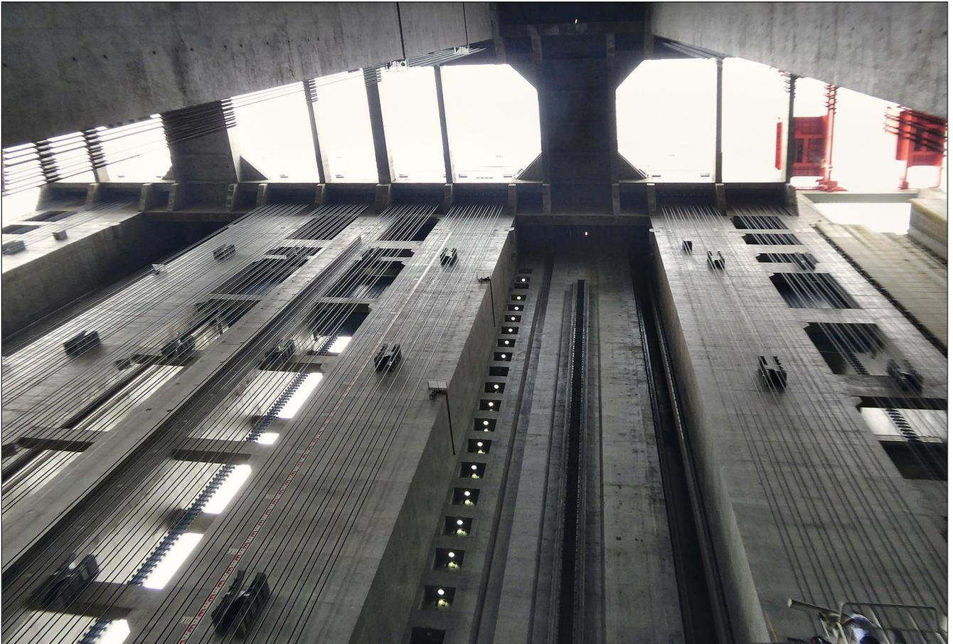
Bild 13: Aufgehender Stahlbetonturm mit Zahnstange (in der Nischenmitte), Mutterbackensäule (in der Nische rechts) und Seilführung 2017
