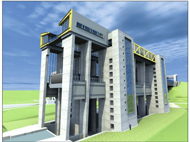
Bild 11: Die klassische Aufgabenteilung von tragenden und getragenen Bauteilen spiegelt sich in der Materialentscheidung für Beton und Stahl wider.
