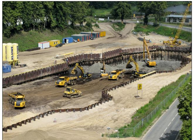
Bild 6: Baugrubenaushub
