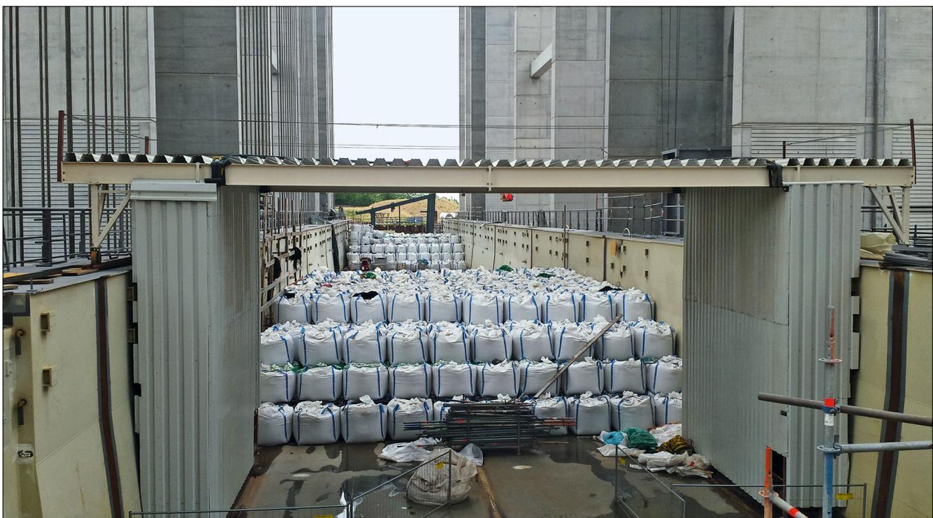
Bild 17: Ballastierung des Troges bei der Gegengewichtsmontage
