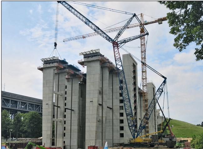
Bild 17: Einbau des letzten Trägerteilstücks
