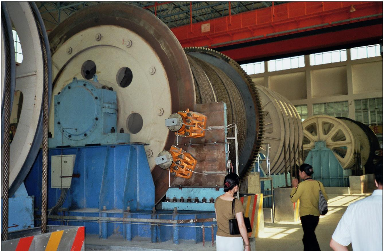
Bild 2: Hebwerk Geheyan, Antriebs- und Sicherungssystem (Scheibenbremsen) im Bereich der Seilscheiben
