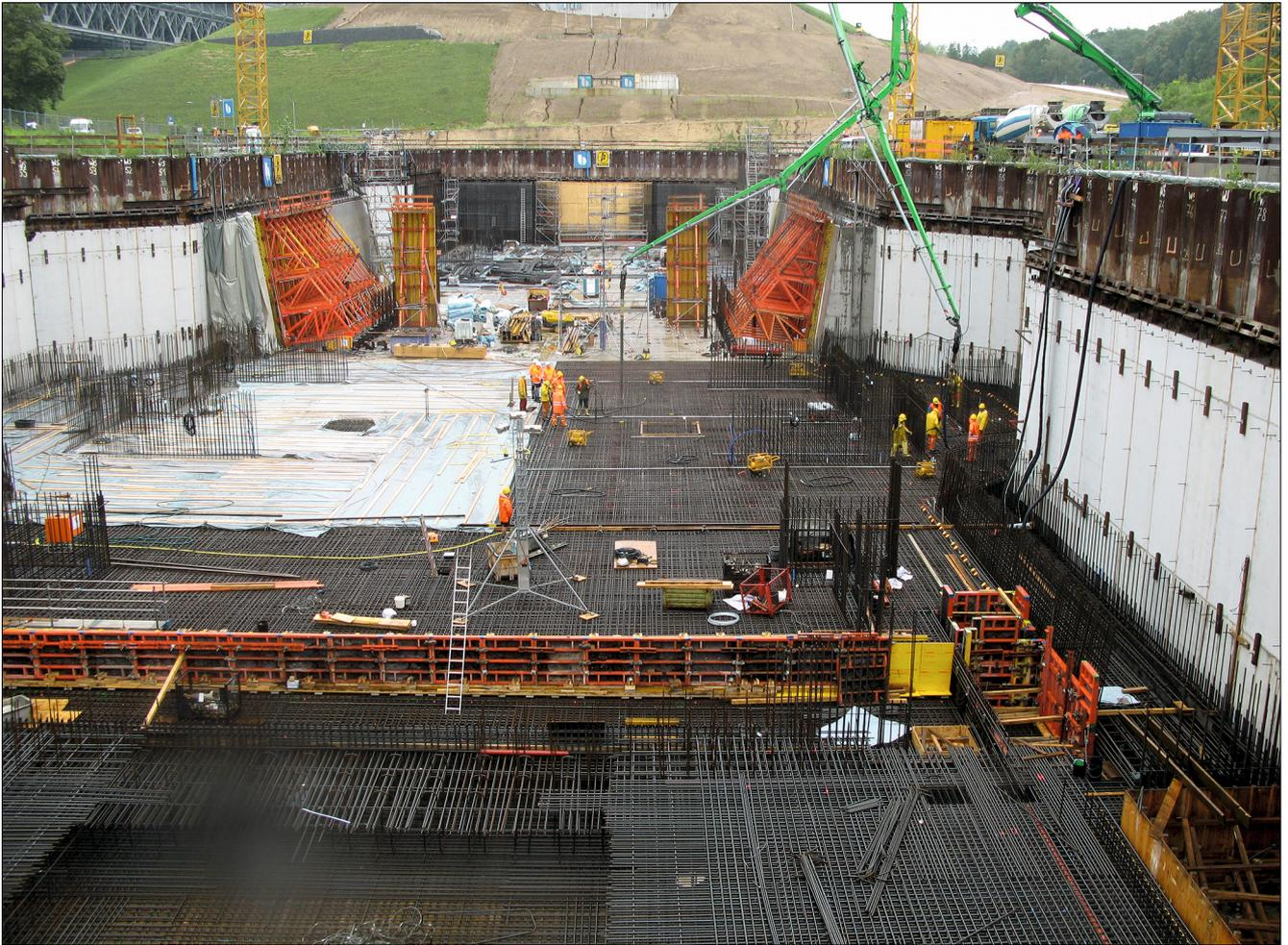
Bild 4: Bewehrungs- und Betonarbeiten Sohle und Trogaußenwand (Juli 2011)
