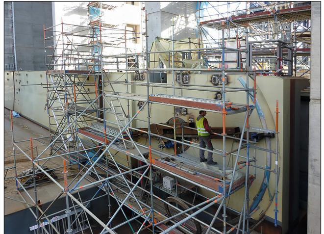
Bild 15: Mechanische Bearbeitung Seitendichtfläche
