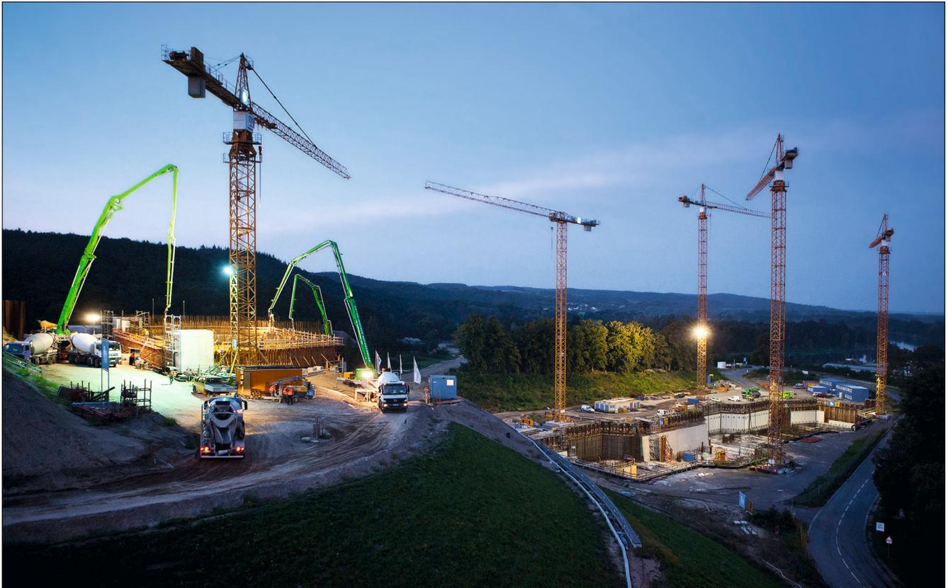
Bild 13: Betonage Widerlager
