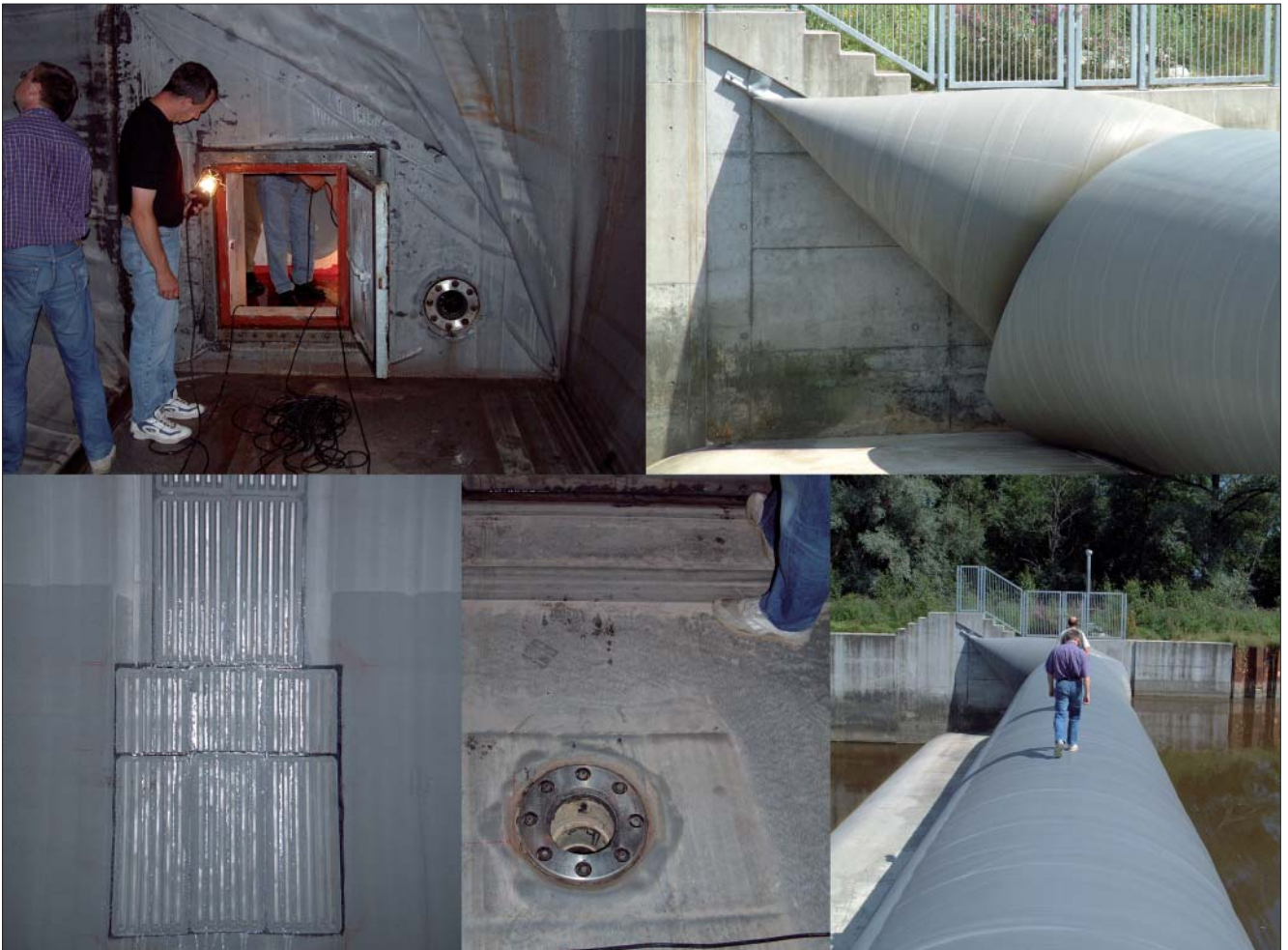
Bild 6: Schlauchwehr Türkheim an der Wertach: oben links) Druckschleuse an der rechten Wehrwange, oben rechts) seitlicher Anschluss, unten links) Sickermatten (engl. drain pads), unten Mitte) Ein- bzw. Auslassöffnung, unten rechts) Blick vom linken Ufer
