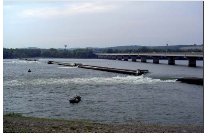
Bild 2: Sunbury Dam mit teilweise abgelegten Schlauchwehren [7]
