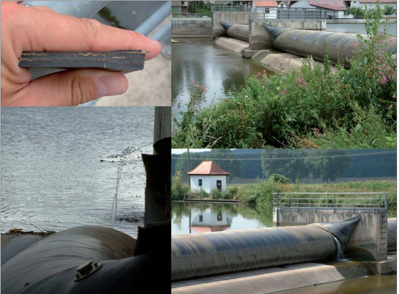
Bild 12: Schlauchwehr Baiersdorf an der Regnitz: oben links) Querschnitt der zweilagig verstärkten Schlauchmembran, oben rechts) Wehranlage vom Unterwasser, unten links) Leckage durch Vandalismus, unten rechts) Mittelpfeiler
