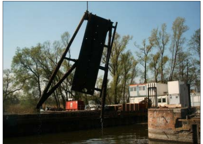
Bild 11: Abbruch der alten Wehranlage
