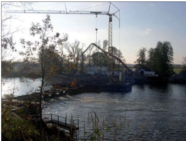
Bild 14: Betonage der Unterwasserbetonsohle
