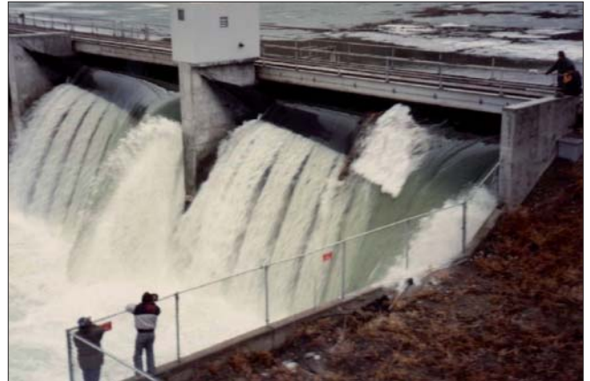
Bild 3: Broadwater Dam, USA (luftgefüllt, sieben Wehrfelder à 16,5 m, Schlauchhöhe 3,4 m) [5]
