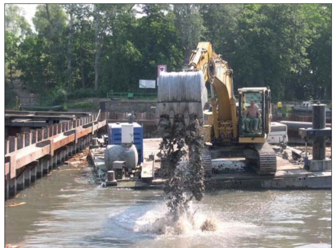
Bild 12: Ausbaggerung der Baugrube
