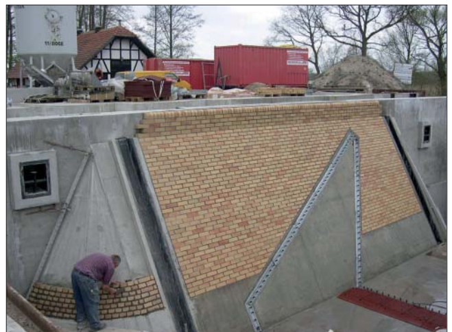
Bild 21: Verklinkerern der Pfeiler
