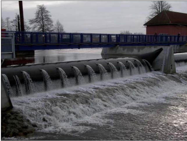
Bild 4: Inbetriebnahme der Wehranlage
