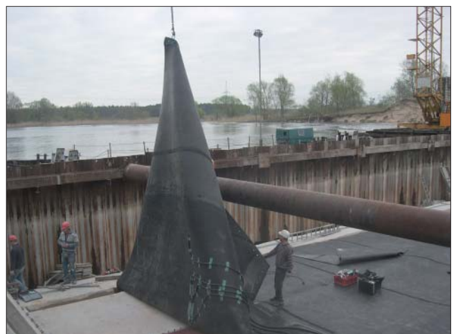
Bild 22: Einbau Schlauchverschluss
