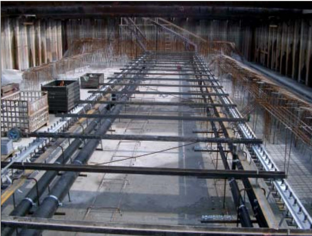
Bild 18: Einbau der Rohrleitungen zur Schlauchwehrsteuerung
