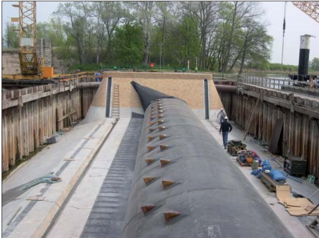
Bild 23: Test auf Dichtigkeit des Schlauchverschlusses
