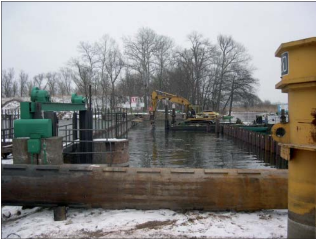
Bild 8: Schlitzen des vorhandenen Bauwerkes
