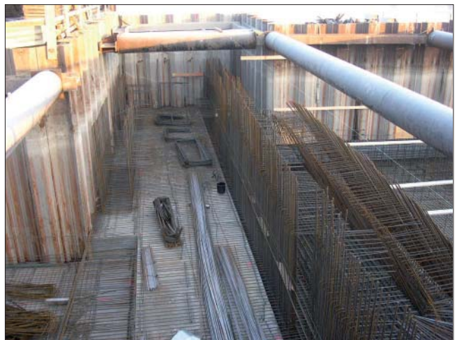
Bild 17: Einbau der Bewehrung für die Kahnschleuse
