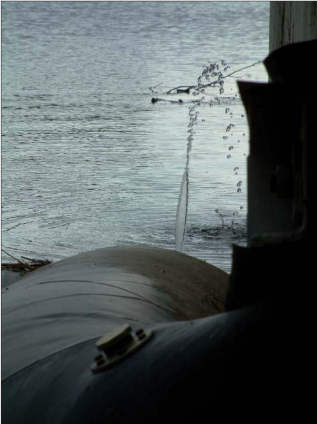
Bild 2: Leckage am Schlauchwehr Baiersdorf (wasser-gefüllt, zwei Wehrfelder à 27,0 m, Schlauchhöhe 1,85 m, Membrandicke 8,0 mm)
