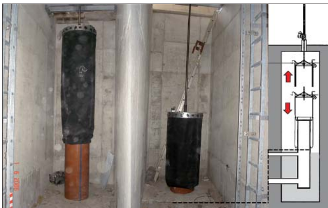
Bild 8: Steuerbalg in Höchst- und Tiefstellung
