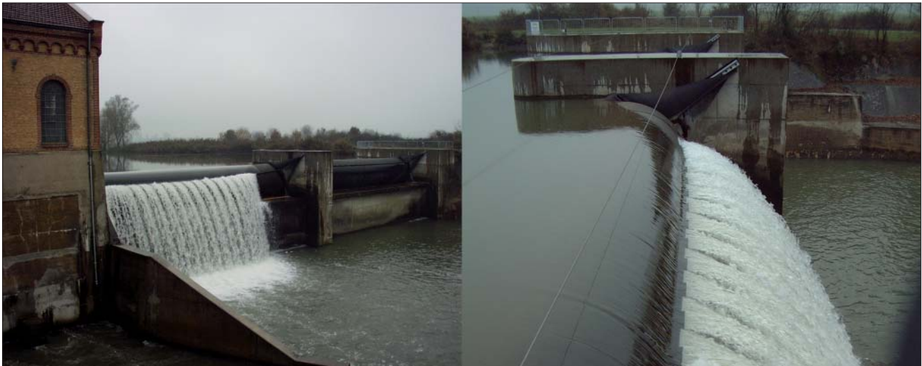
Bild 7: Schlauchwehr Kiebingen am Neckar: links) Krafthaus mit Wehranlage, rechts) Blick vom rechten Ufer
