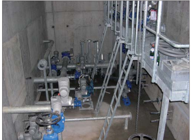
Bild 25: Installation der Pumpenanlage im Schachtbauwerk zur Schlauchwehrsteuerung
