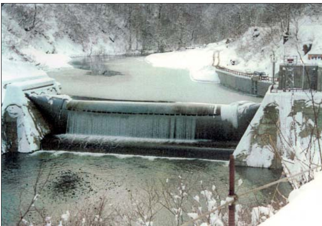
Bild 12: Schlauchwehr Baiersdorf an der Regnitz: oben links) Querschnitt der zweilagig verstärkten Schlauchmembran, oben rechts) Wehranlage vom Unterwasser, unten links) Leckage durch Vandalismus, unten rechts) Mittelpfeiler
