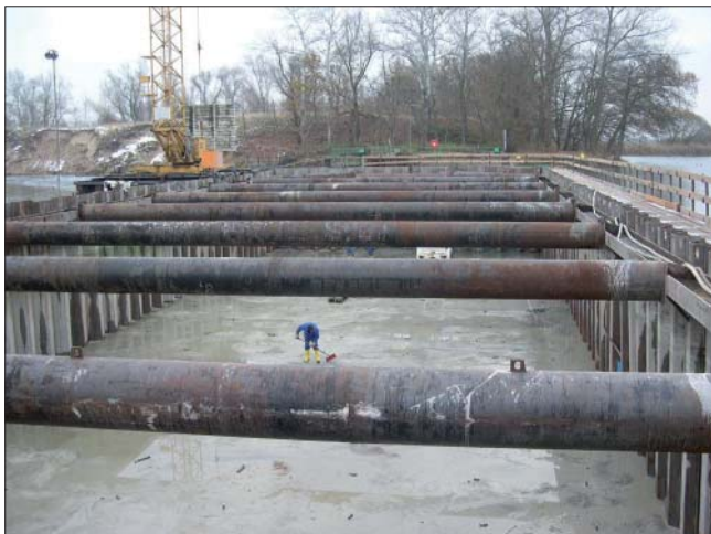
Bild 15: Reinigung nach Trockenlegung der Unterwasserbetonsohle
