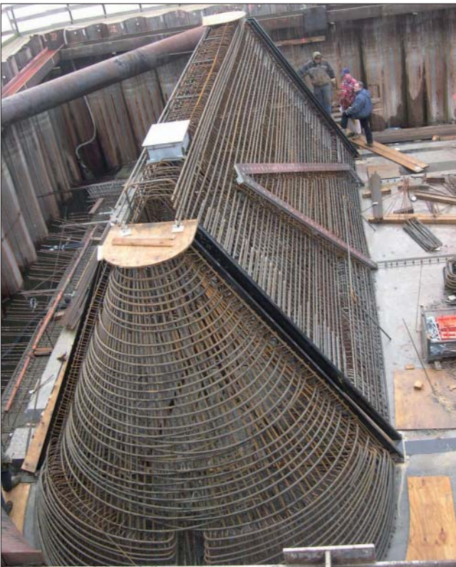
Bild 19: Einbau der Bewehrung für den Mittelpfeiler
