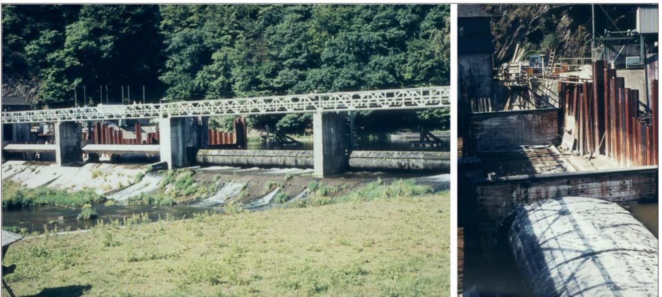
Bild 3: links: Blick vom Unterwasser auf die Wehranlage Hollerich mit dem im Bau befindlichen Schlauchwehr vor dem rechten Wehrfeld; rechts: Baustelle mit gefülltem Schlauchwehr
