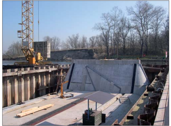
Bild 20: Fertig betonierte Wehrschwelle und Pfeiler
