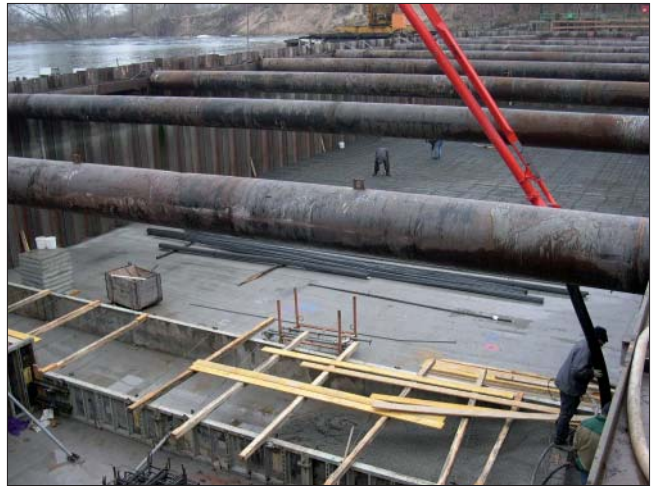
Bild 16: Einbau der Bewehrung in der Wehrsohle
