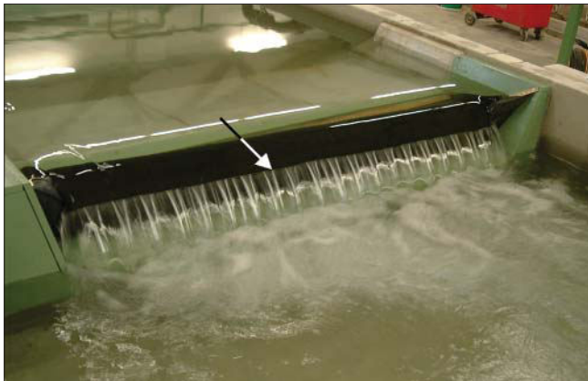
Bild 11: Foto des Schlauchwehrs (vor Einbau der Messtechnik)
