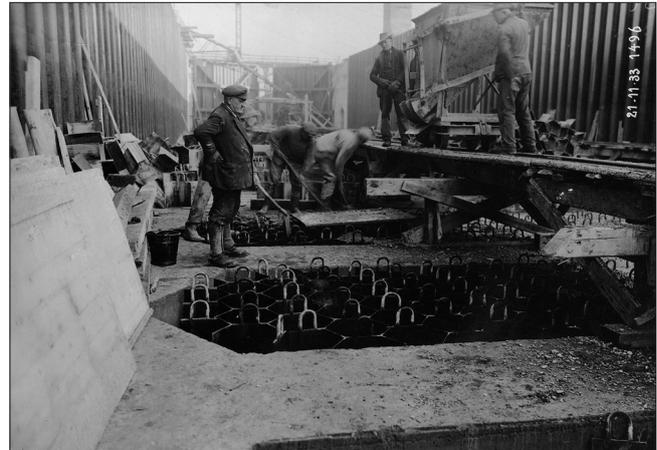
Bild 3: Herstellung des Sohlpflasters
