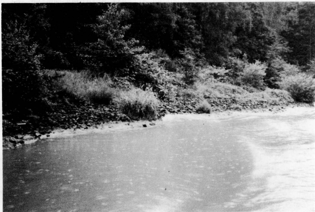
Bild 12: Uferbewuchs am Wesel-Datteln-Kanal 10 Jahre nach Ausbau (asphaltverklammertes Deckwerk)
