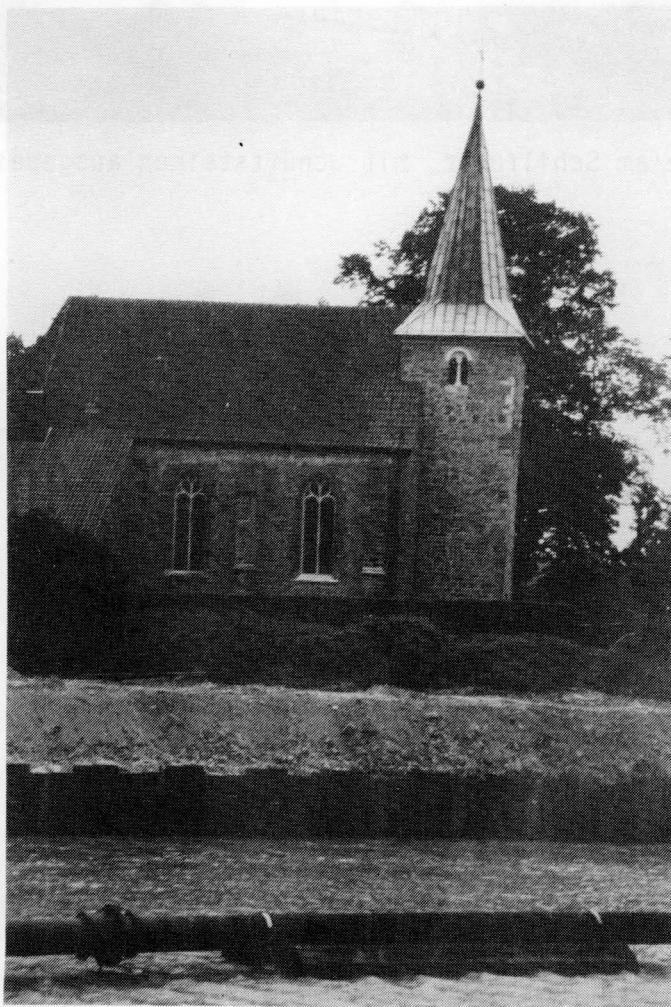
Bild 8: Spundwand vor der Kirche Hamm-Bossendorf am Wesel-Dattel-Kanal
