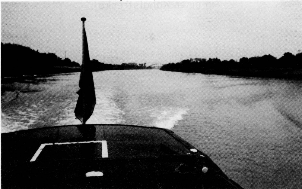
Bild 11: Ausgebauter Wesel-Datteln-Kanal mit RT-Profil
