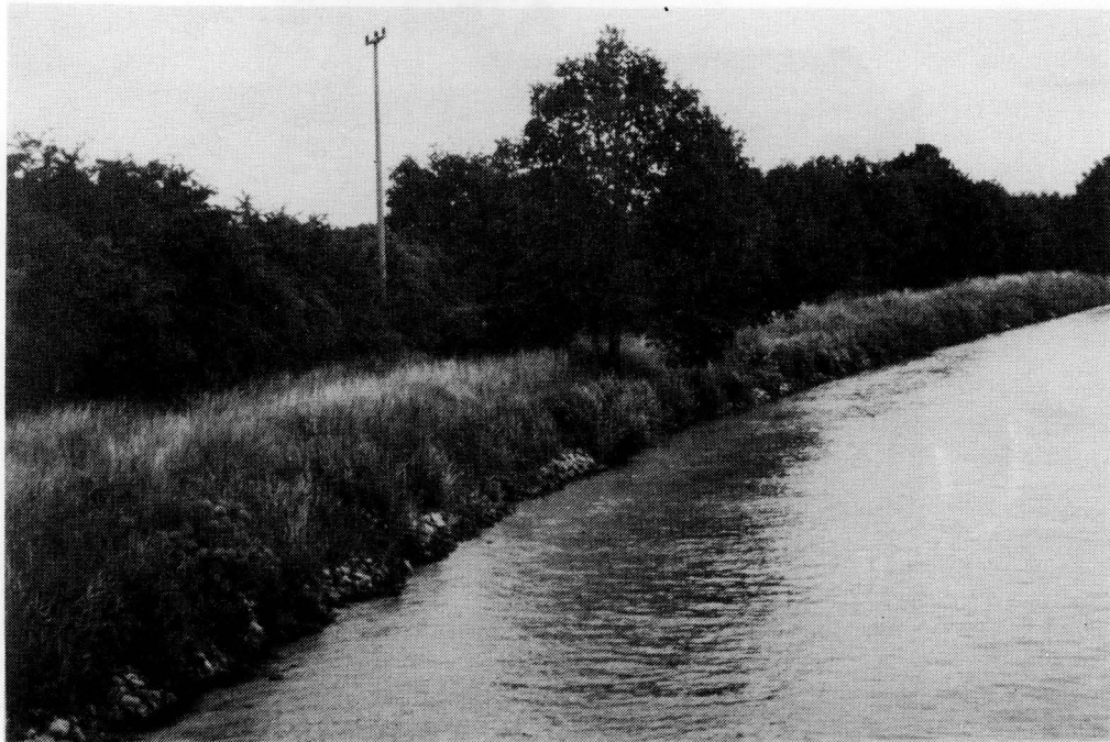
Bild 7: Böschungsufer am stark befahrenen Dortmund-Ems-Kanal
