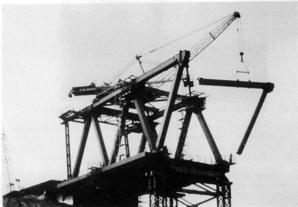
Bild 14: Montage auf der Nordseite der Hochbrücke Grüental
