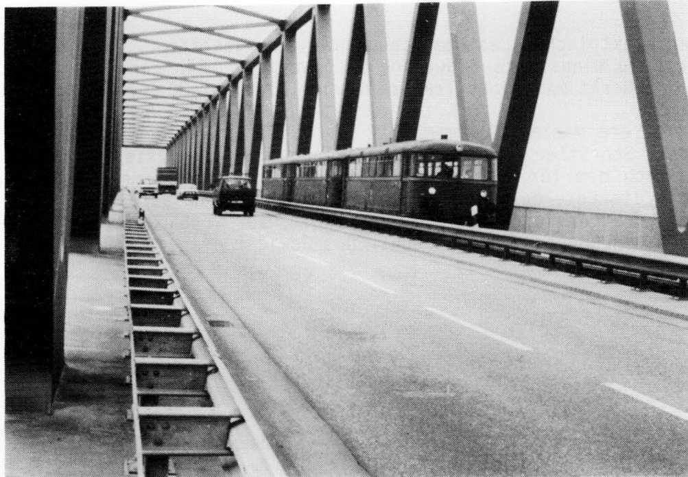
Bild 17: Neue Hochbrücke Grünental unter Verkehr
