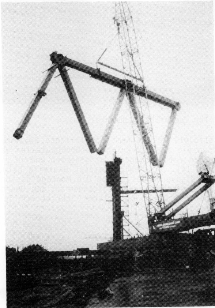
Bild 15: Montage auf der Südseite der Hochbrücke Grüental
