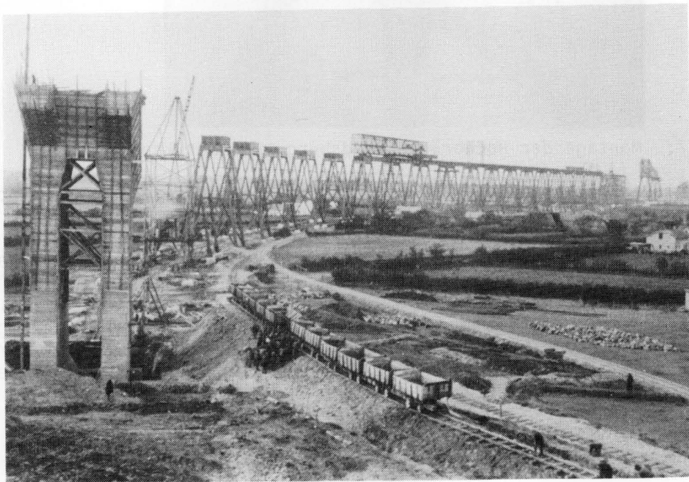
Bild 6: Montage der Hochbrücke Rendsburg, Rampen
