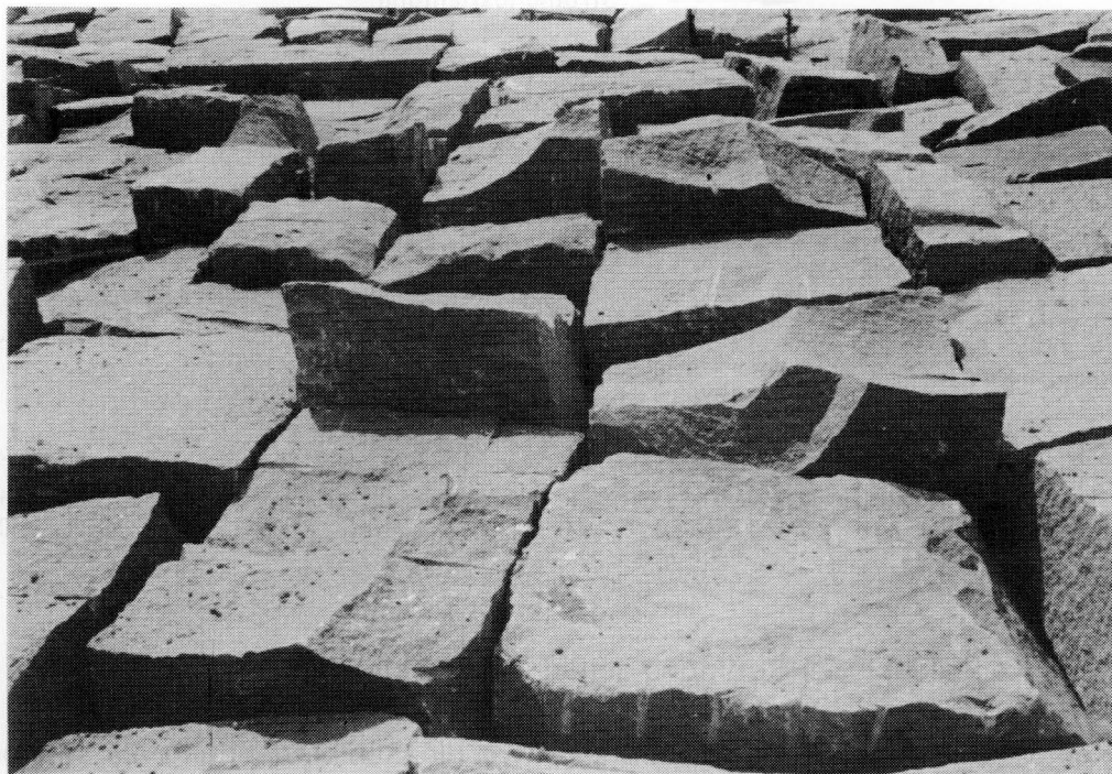
Bild 51 Gesetzte Granitquadersteine in der starren Sohlensicherung
