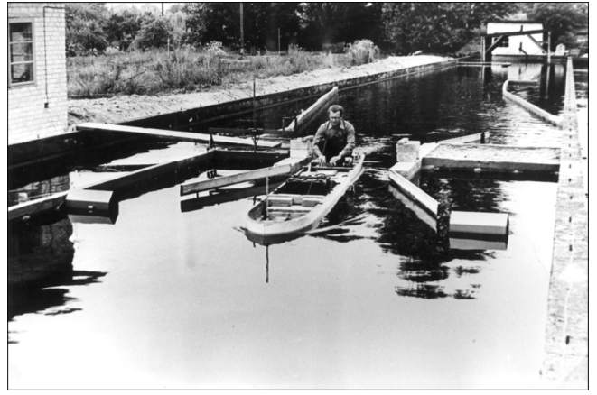
Bild 16: Sperrwerksdurchfahrt mit personengesteuertem Schiffsmodell
