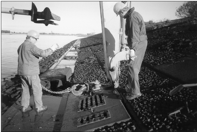
Bild 11: Verschließen des Probefeldes mit einer durchlässigen Betonplatte
