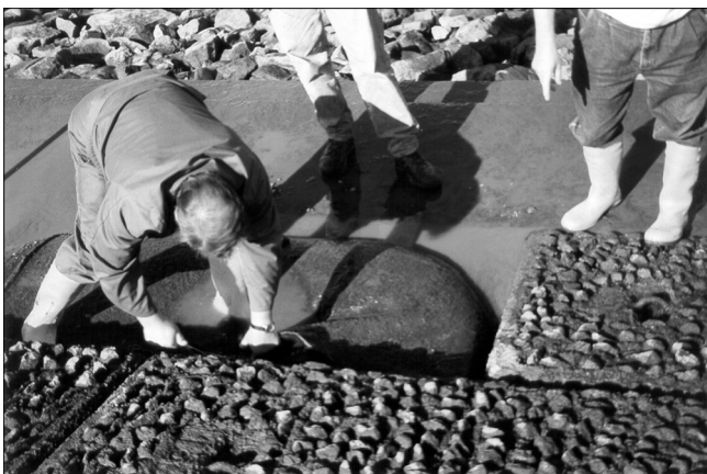
Bild 6: Aufgebrochene Entwässerungsöffnung
