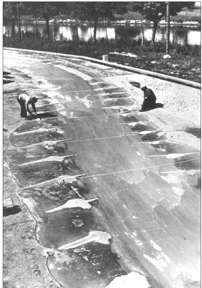
Bild 3: Modell der Elbe bei Schönebeck, Aufmessung der umgebildeten Modell-Flusssohle
