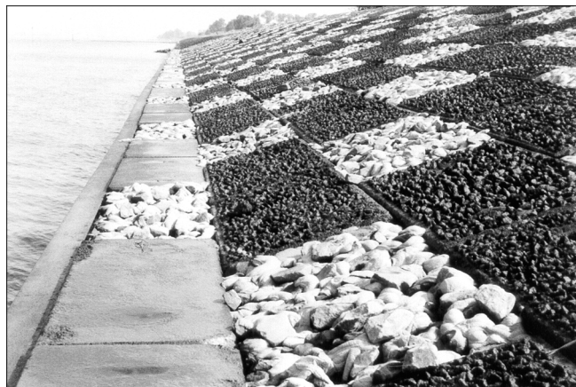
Bild 5: Heutiges Plattendeckwerk nach der Grundinstandsetzung 1983/84
