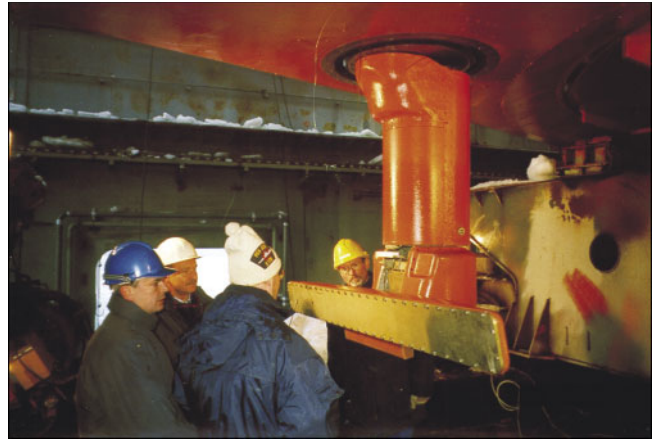
Bild 8: Baubesprechung NEUWERK – Einbau Sonaranlage
