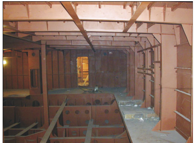
Bild 3: Längs- und Querverbände
