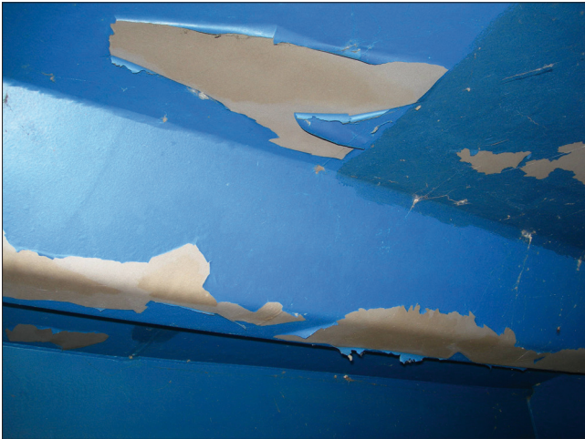
Bild 2: Typisches Schadensbild bei der Enthftung der DB beim Blatt 87-System
