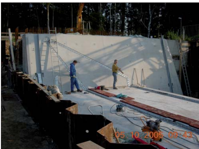
Bild 5: Klemmschiene am Pfeiler und auf der Wehrsohle
