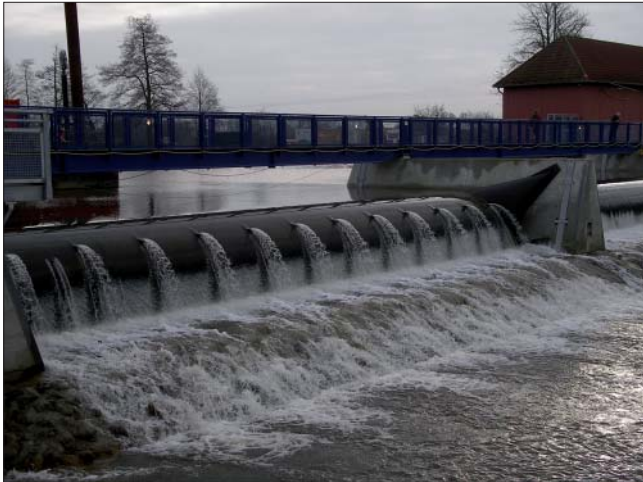
Bild 4: Inbetriebnahme der Wehranlage
