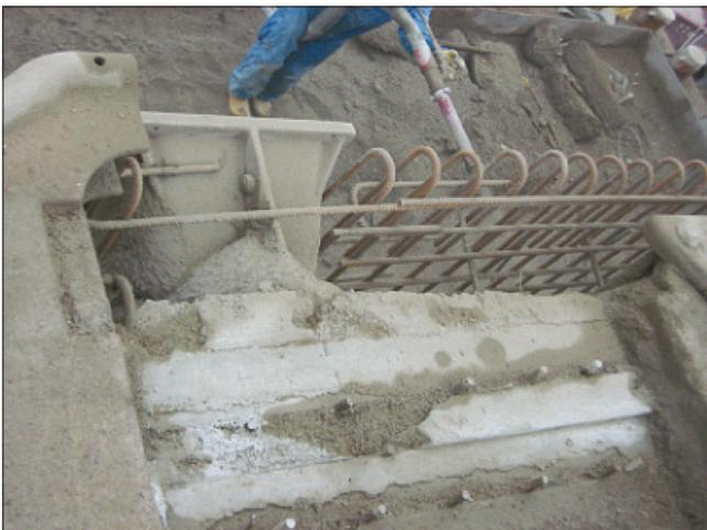
Bild 15: Einbau eines Nischenpollers
