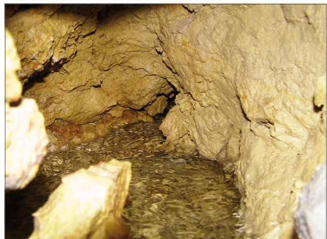
Bild 7: Beim Aushub der Baugrube angeschnittene Kluft
