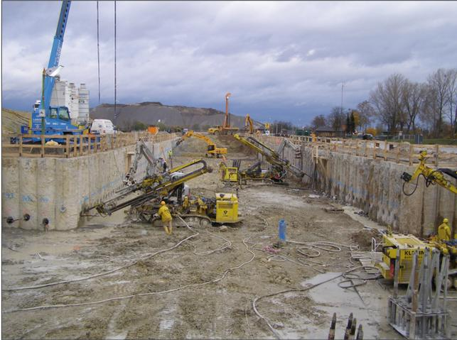
Bild 13: Herstellung der Verankerung
