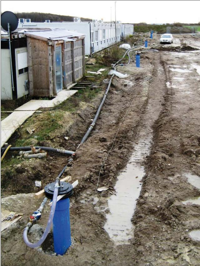
Bild 12: Anordnung der Infiltrationsanlage im Zustrombereich zur Baugrube
