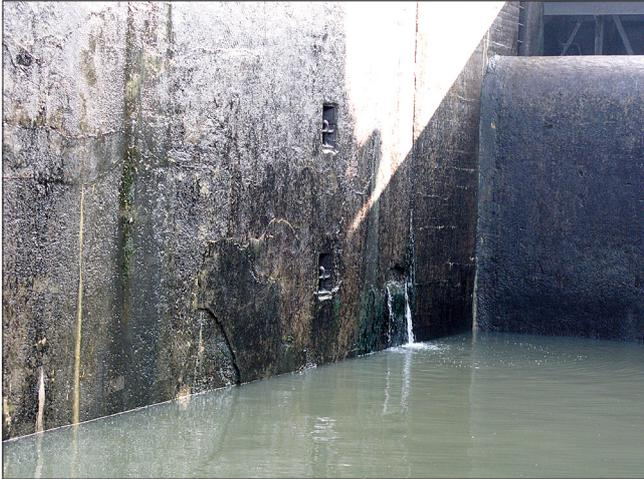
Bild 20: Wasserdurchtritt infolge rückseitiger Durchfeuchtung
