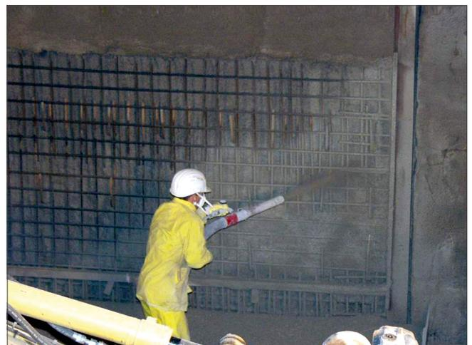
Bild 12: Spritzbetonauftrag 2. Lage
