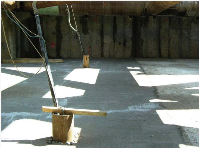
Bild 10: Entlastungsbrunnen zur Auftriebssicherung der Bauwerkssohle
