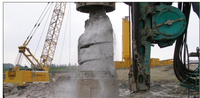
Bild 12: Durchörterung einer Gipsschicht
