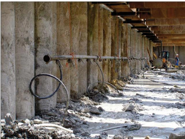
Bild 8: Entlastungsbrunnen zur Vermeidung eines hydraulischen Grundbruchs im Bereich der Bohrpfehlwand.
