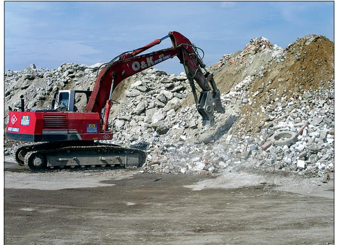
Bild 2: Grobaufbereitung des Betons
