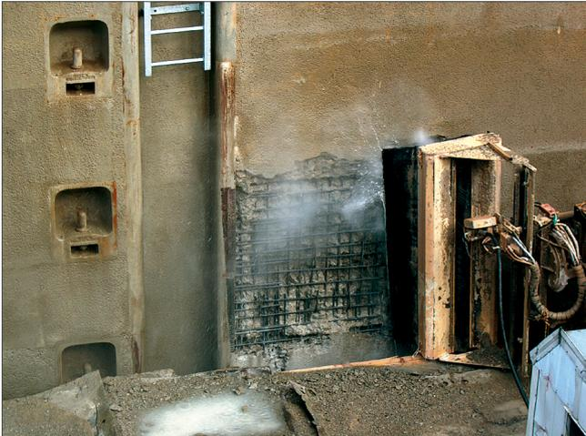
Bild 26: Abbruch der vierten Lamelle mittels HDW
