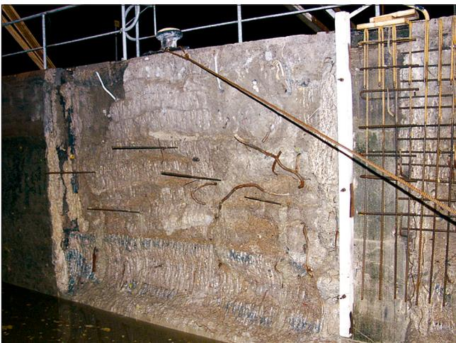
Bild 23: Bewehrungseisen im Altbeton
