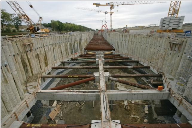
Bild 8: Erste Steifenlage am Unterhaupt
