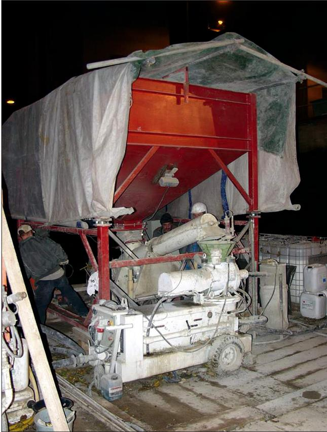
Bild 9: Spritzbetonanlage auf dem Arbeitsponton
