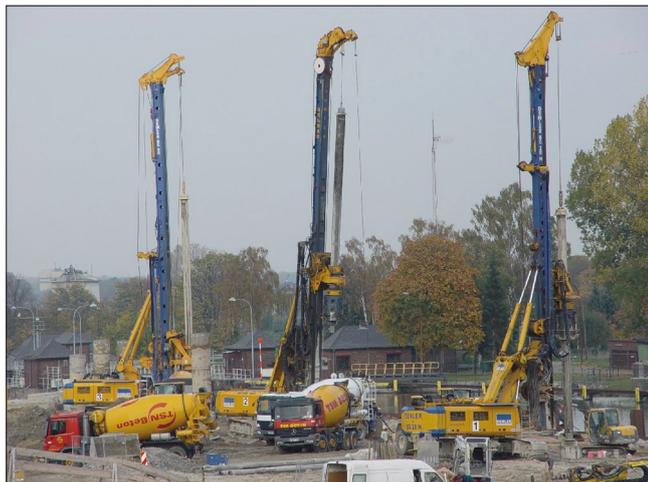
Bild 11: Herstellung der Bohrpfahlwand
