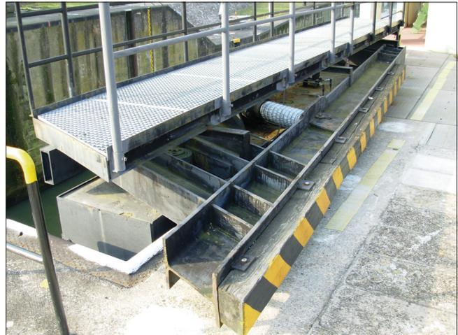
Bild 2: Direkt am Stemmtorflügel angebrachte Stoßschutzeinrichtung
