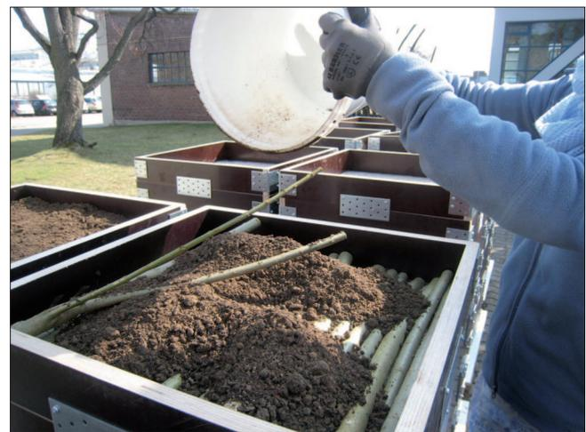
Bild 16: Einbau und Übererdung der Weidenspreitlagen am 15. März 2012
