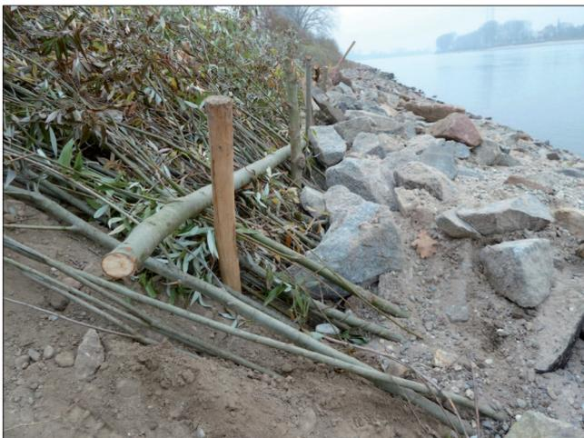
Bild 1: Weidenspreitlagen, in die Steinschüttung einbindend
