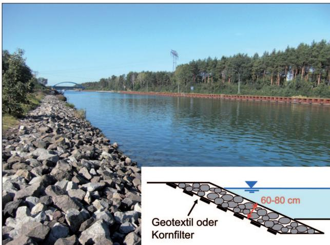
Bild 6: Technisches Deckwerk aus losen Wasserbausteinen
