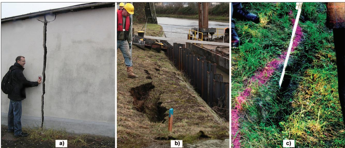
Bild 1: Auswirkungen von Vibrationsrammungen auf Baugrund und Bauwerke: a) Bauwerksriss durch ungleichmäßige Setzungen, b) Einbrüche im Uferbereich, c) Böschungsabriss im Kanalseitendamm
