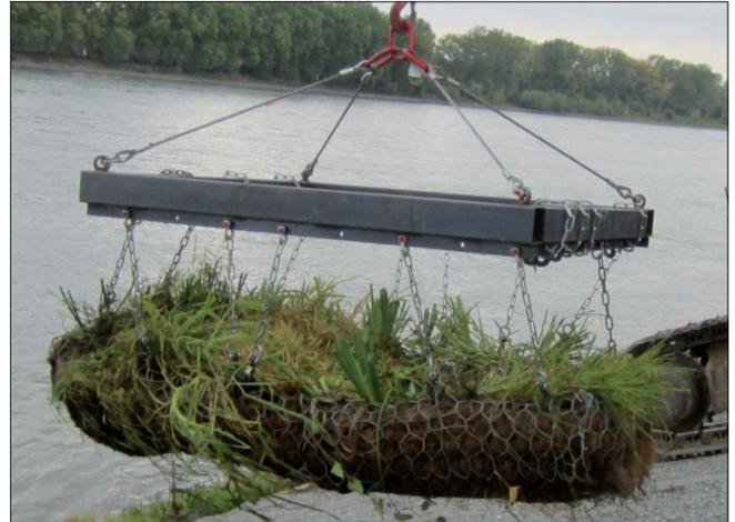
Bild 2: Röhrlichtgabionen – vorgezogene Einzelelemente
