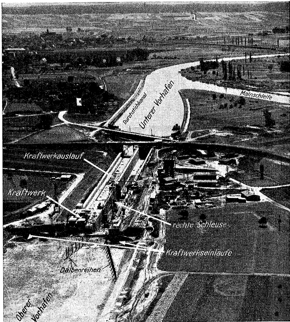
Bild 14 Schleuse und Kraftwerk der Mainstaustufe Gerlachshausen. Bauzustand im September 1956.
