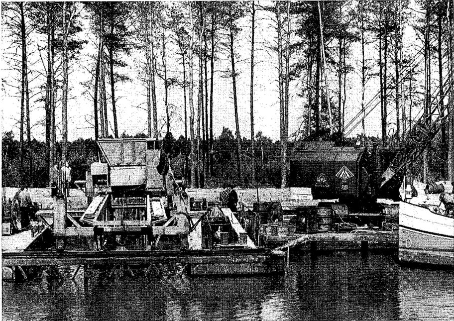
Bild 12 Gerät zum Einbau der Tondichtung beim Einsatz im Dortmund-Ems-Kanal, Haltung Altenrheine-Venhaus
