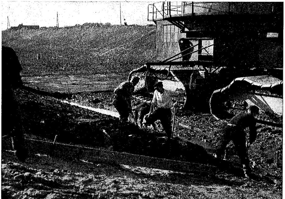
Bild 4 Einbau des Hydratons in der Böschung
