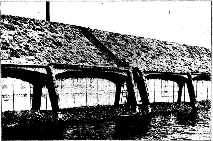
**Bild 8: Böschung mit Betonbohlwerk in der Ansicht**
