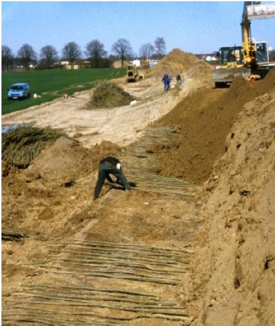
Bild 5: Auslegen und Einerden von Pflanzen auf einer Berme und Verdichten mit einer Vibrationswalze
