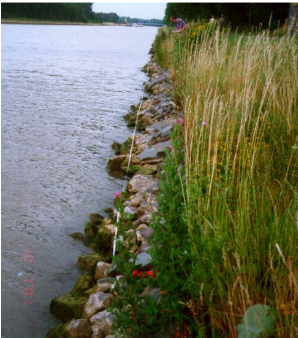
Bild 5: Steinumlagerungen am Kanalufer
