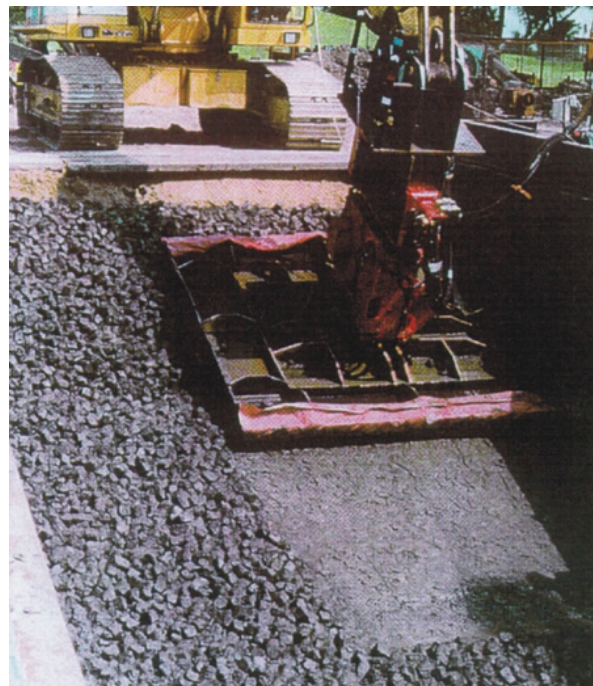
Bild 3: Tonwürfelverfahren (Fa. L.Freytag)
