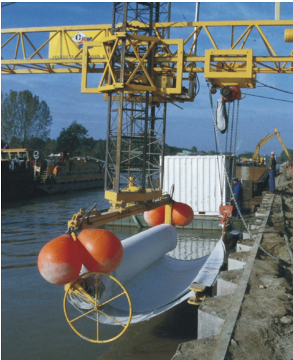
Bild 4: Verlegung der GTD
