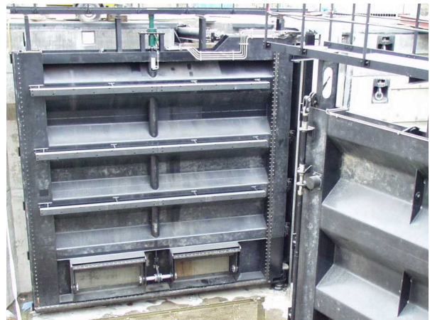
Bild 7: Faltwerk-Stemmtor mit Segment-Torschützen
