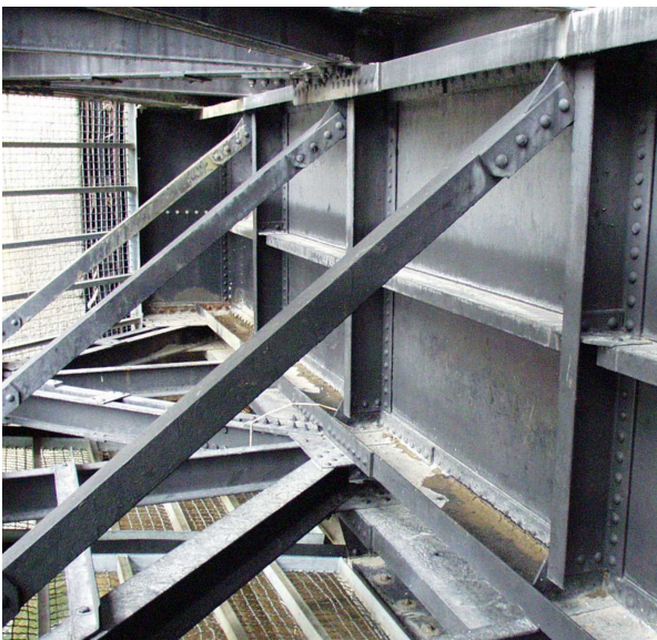
Bild 1: Fachwerk-Nietkonstruktion eines Wehrverschlusses (Baujahr 1915)
