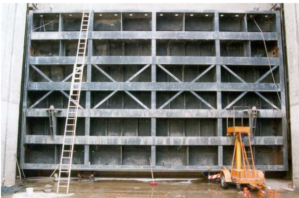
Bild 2: Voll geschweißtes Hubtor aus dem Jahre 1940
