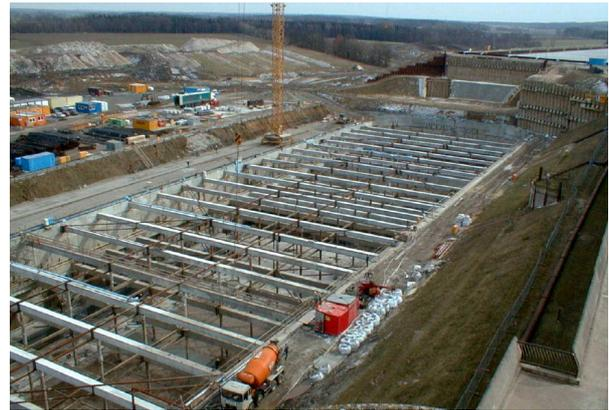
Bild 9: Baugrubenverbau
