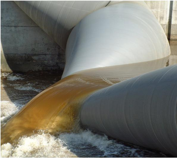
a. Einknicken bei Luftfüllung
