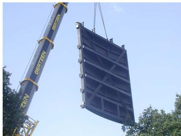
**Bild 8:** Einbau eines neuen Untertores
