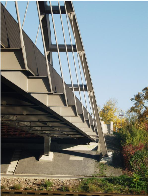
**Bild 23:** Der Sichelbogen als Tragwerkstyp für die Brücke Pasteurallee
