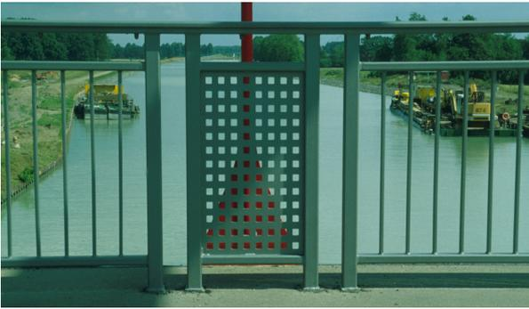
Bild 19: Ausgeführtes geschlossenes Geländerfeld in der Hängerachse
