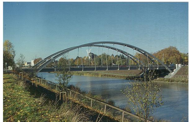
**Bild 24:** Große Transparenz durch fehlende Flügelwände, Pasteurallee
