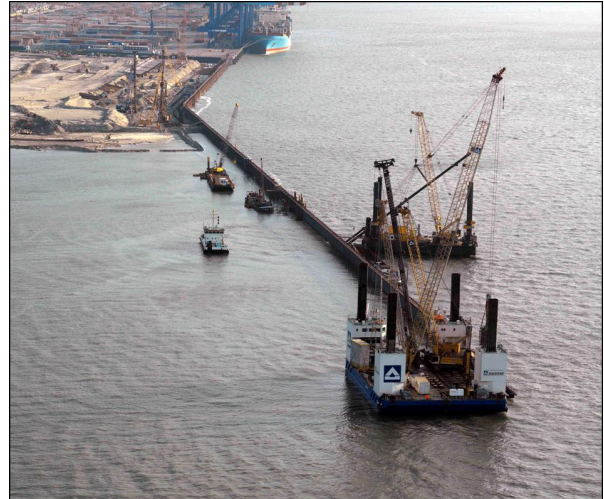
Bild 1: Kajenbau am Container Terminal 4
