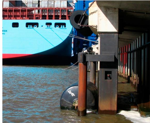
Abb. 11: Fendertafel mit Schwimmfender
