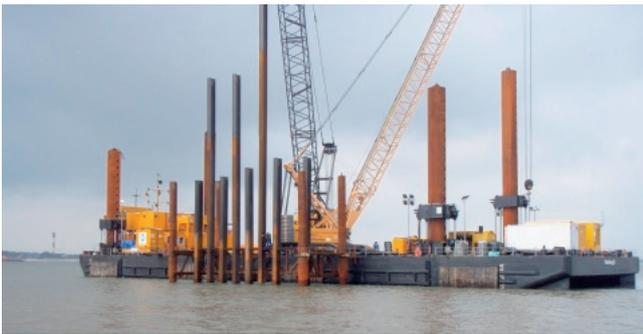
**Abb. 16:** MP 45 beim Rammen der Tragbohlen für die Kaje (Hauptwand)
