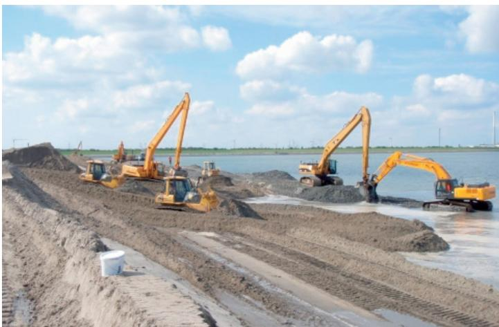
Abb. 20: Hinterfüllung der 2ten Schüttlage am Norddamm
