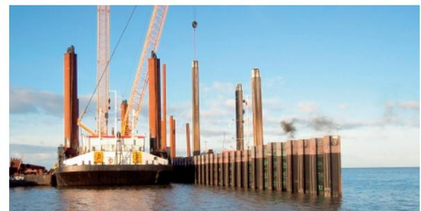
**Abb. 15:** Interocean beim einbringen der Tragbohlen der Hauptwand
