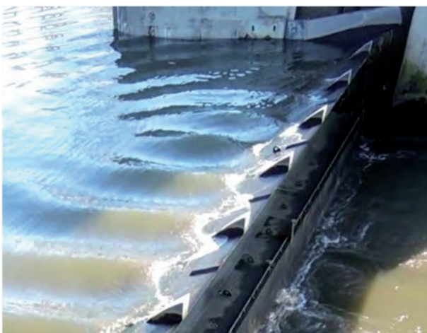
Abbildung 1: a) Schwingung eines Hubschützes mit Aufsatzklappe und
