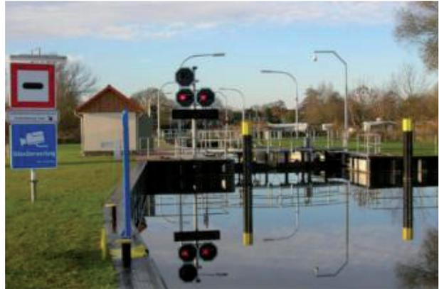
Abbildung 2 (rechts): Selbstbedienungsschleuse an einer kleinen Wasserstraße, die nur für Freizeitwecke genutzt wird. (Quelle: WSA Lauenburg)
