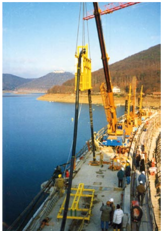
Einbau eines Ankers
