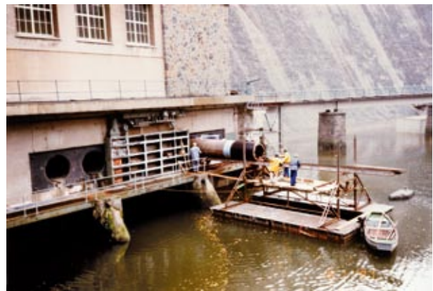
Einbau der neuen Rohre von der Luftseite
