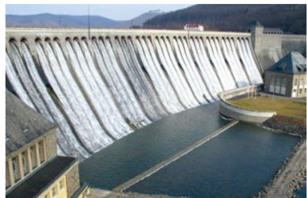
Überlauf an der Talsperre
