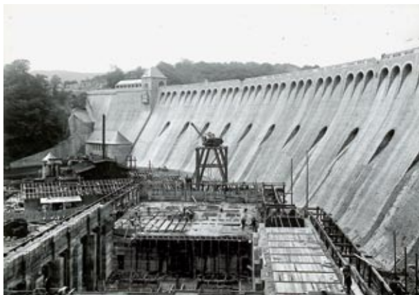
Das Maschinenhaus des Speicherkraftwerks Hemfurth I wurde im Jahr 1914 errichtet. Am 1. Juli des gleichen Jahres war Richtfest, ein Jahr später ging das Kraftwerk ans Netz. Im Hintergrund ist das Schieberhaus für die Grundablässe zu sehen.
