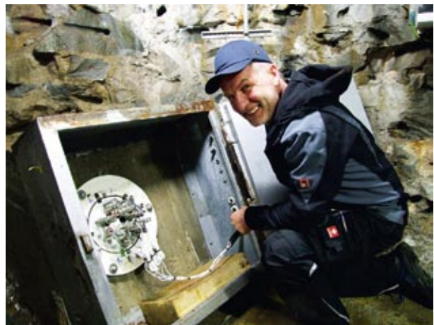
Talsperrenwärter Stephan Daude beim täglichen Kontrollgang
