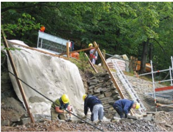
Arbeiter des Außenbezirks beim Befestigen der Ufer
