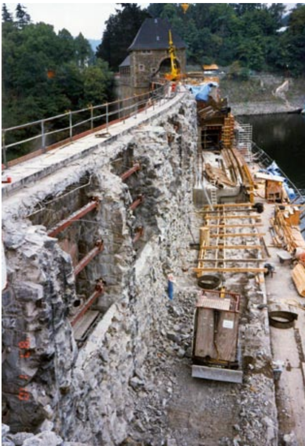
Abbruch der alten Krone mit Erhaltung der Bögen
