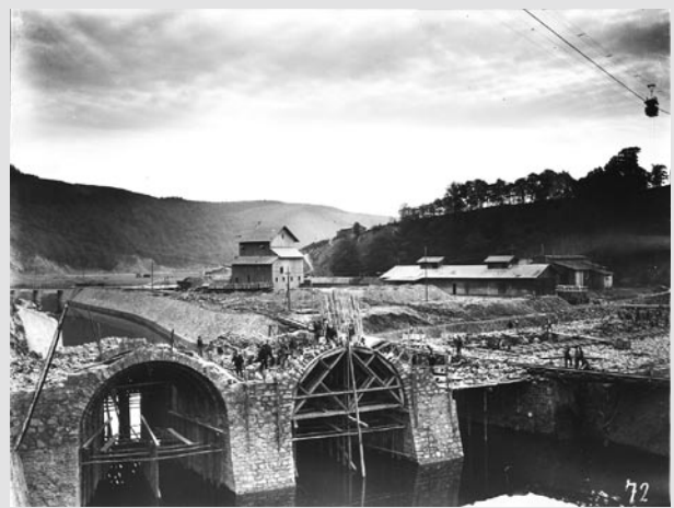
Linker Mauerdurchlass im Bau
