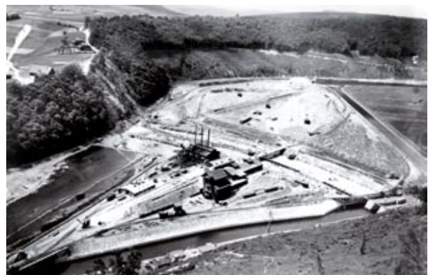
Gesamtansicht der Baustelle
