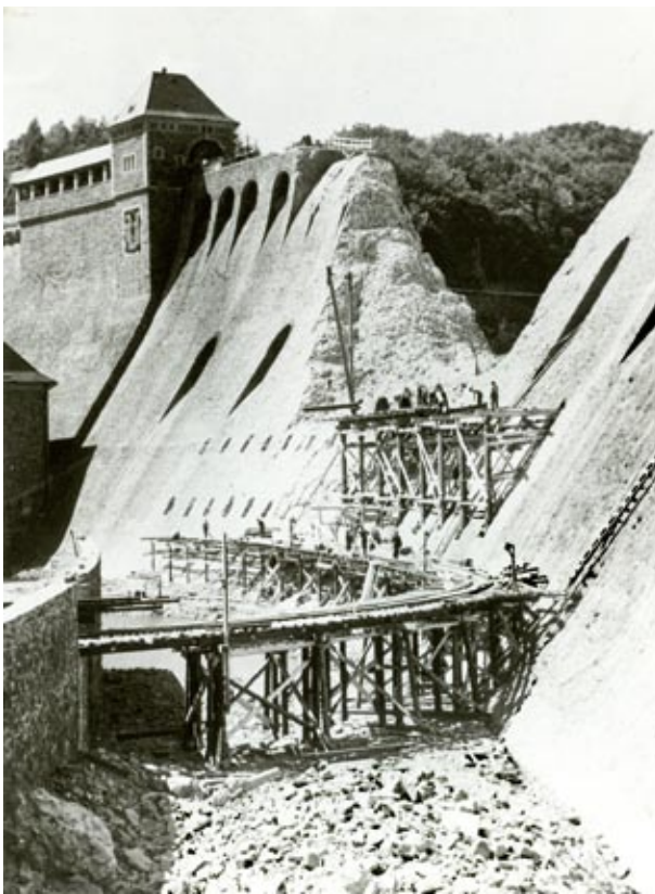
Blick auf die Gleise, die bis direkt an die Mauerlücke reichten.
