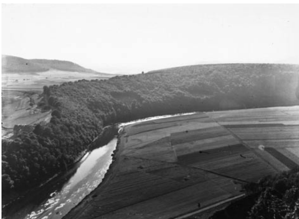
Edertal vor dem Bau der Sperrmauer
