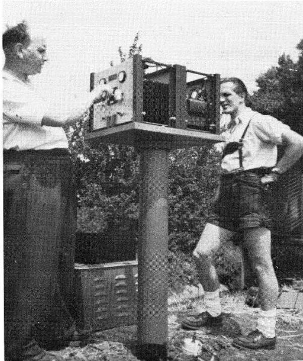
**Abb. 2.5:** Kathodischer Schutzgleichrichter französischer Bauart aus Bogenheim in der Pfalz (1952) [5].
