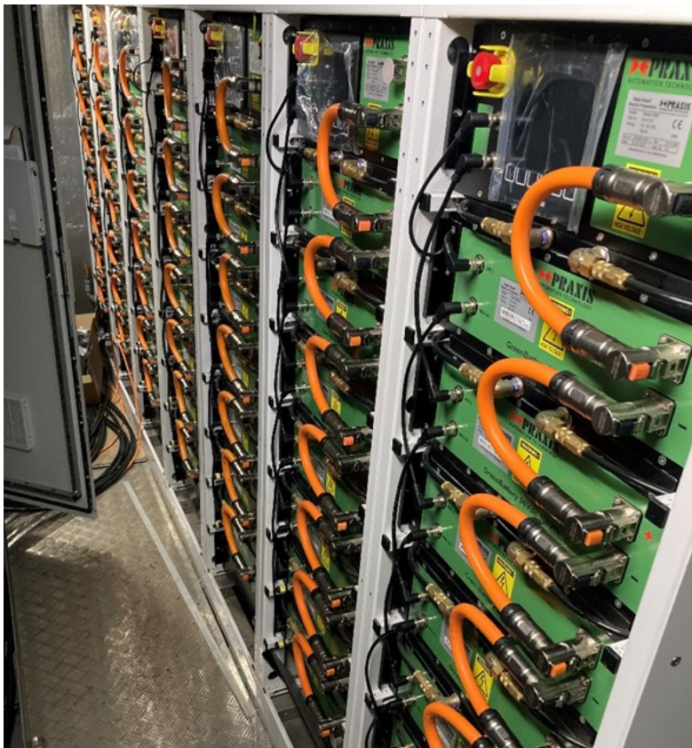
Abbildung 2: Batterieracks
