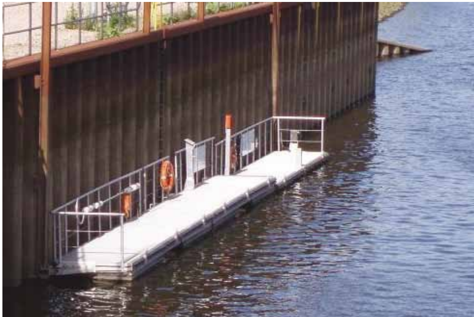
Abb. 14 Schwimmsteg mit unterschiedlichem Freibord (RiGeW, Anhang 4, Bild 17)
