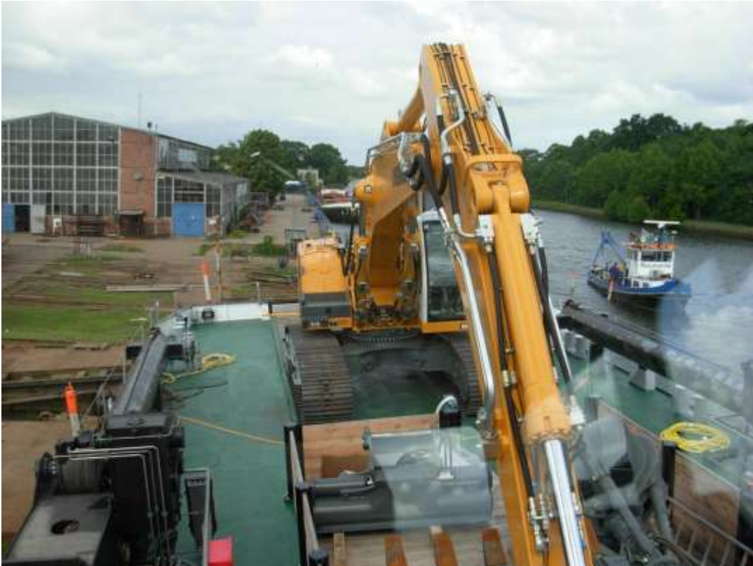
Abbildung 3: SG Stove Sicht aus Steuerhaus auf Arbeitsdeck
