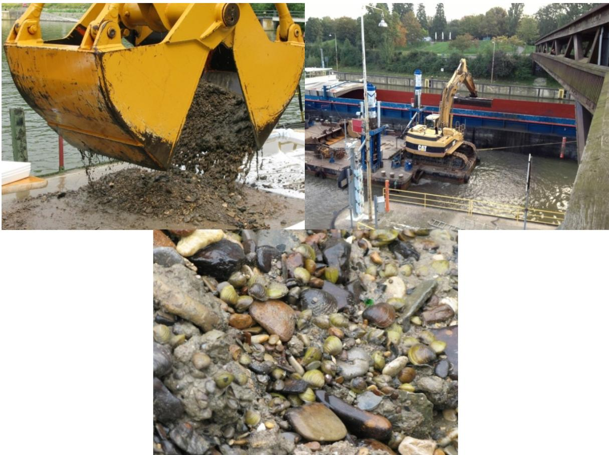
Abbildung 9: Nassbaggerarbeiten entlang des Neckars und anzutreffendes Baggergut
